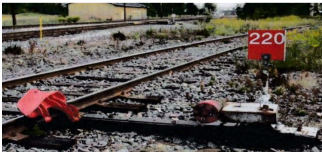
Kuva 15. Raiteen sulku ja sen käsikäyttöinen kääntölaite
