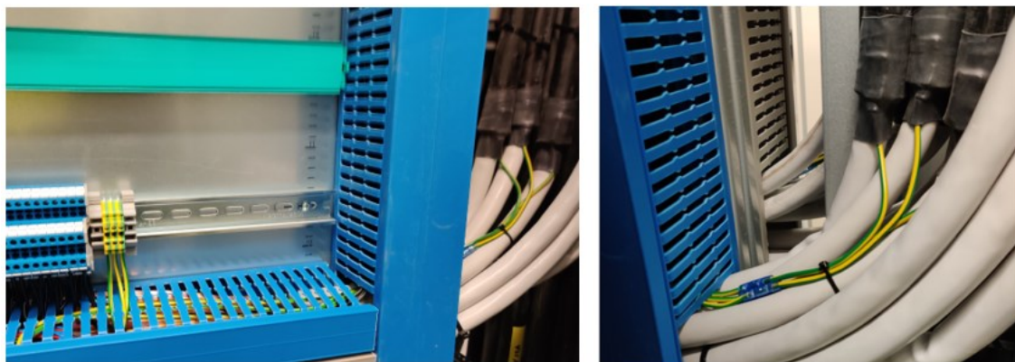
Kuva 4. Armeerauksen yhdistäminen potentiaalintasausjärjestelmään
