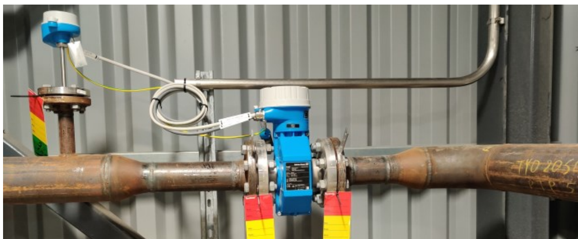
Kuva 11. Esimerkki virtausmittauksen asennuksesta.
