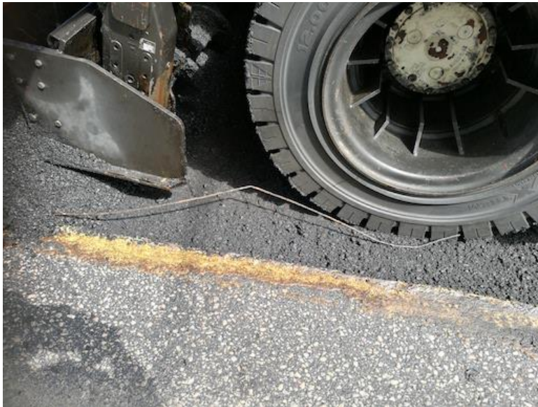
Kuva 15. Verkko tullut näkyviin remix-työn yhteydessä.
