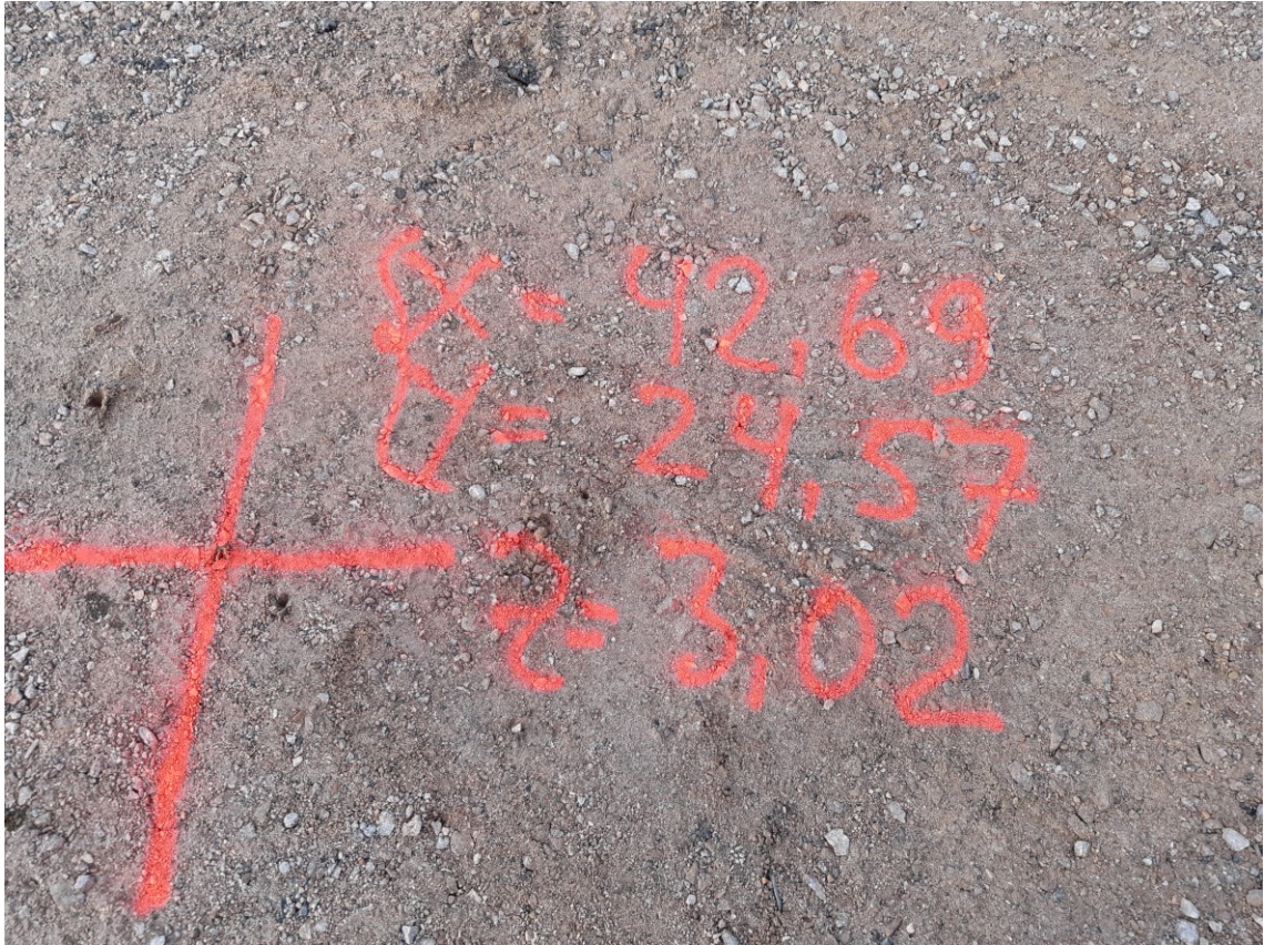
Kuva 12. Esimerkki koneen kalibrointiin liittyvästä tarkistusmittauksesta. Mittamies on merkinnyt kuvaan ristin kohdalla olevan maanpinnan korkeusaseman ja paikan koordinaatit. Koneen kauhan huulilevyn keskipiste asetetaan kuvassa näkyvään ristiin. Koneen ohjausyksikön korkeuden ja paikan arvot tulee vastata kuvan arvoja.
