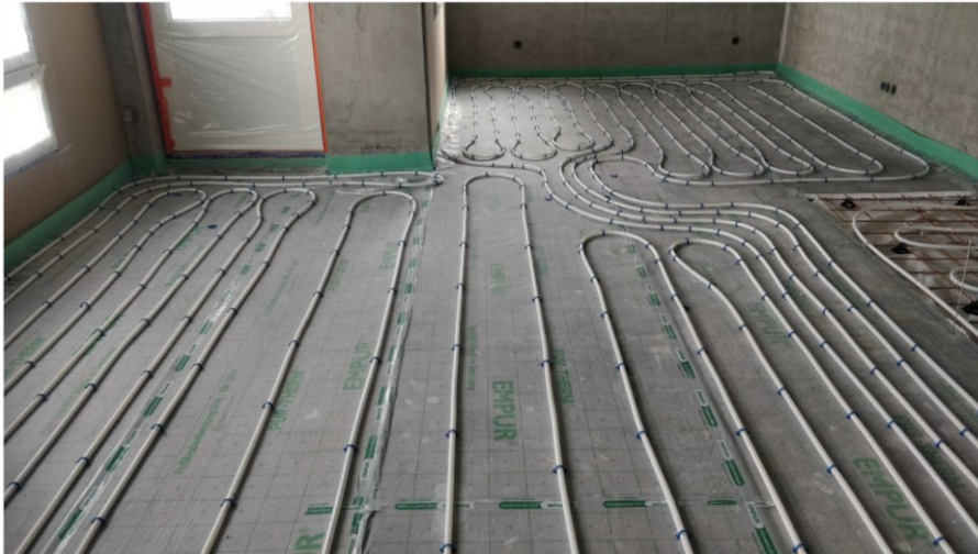
KUVA 6. Huoneiston putkipiirejä
