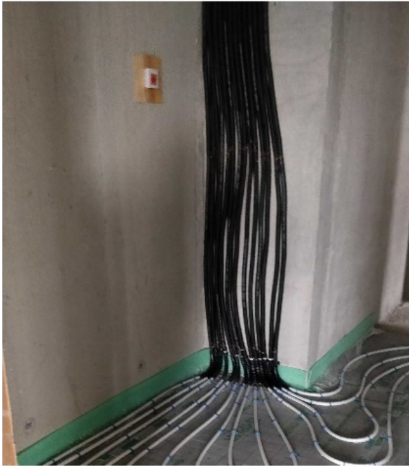
KUVA 3. Putkien reitti huoneiston lattialle
