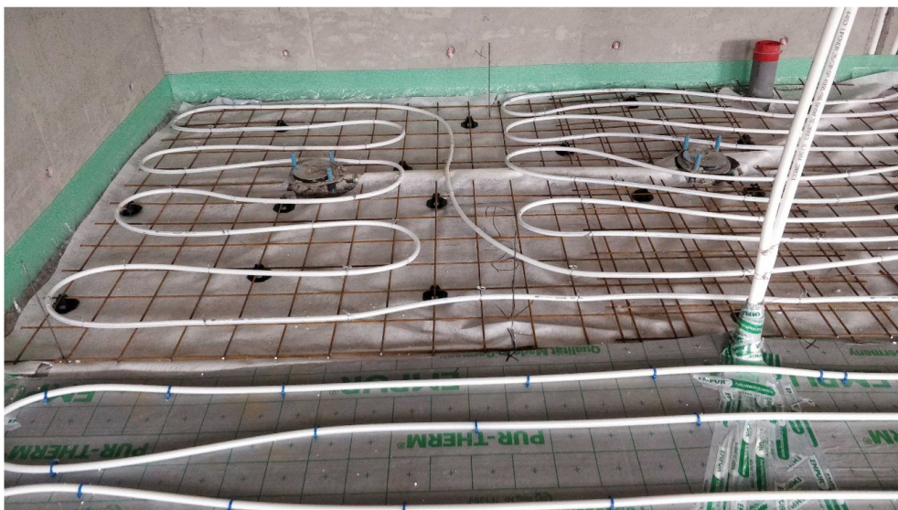
KUVA 5. Lattialämmitysputkien kiinnitys kylpyhuoneen kohdalla
