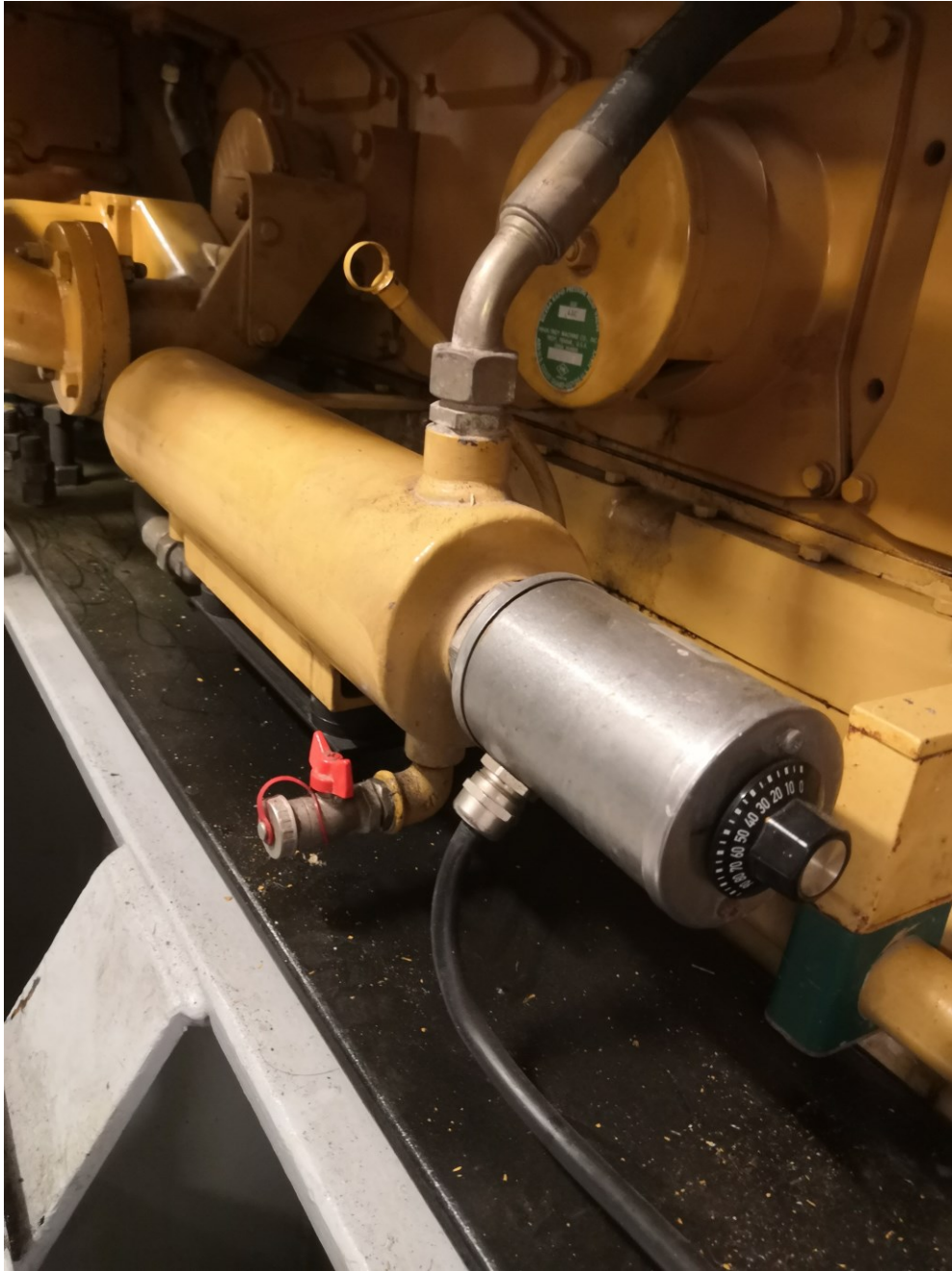
Kuva 3. Lämmitysjärjestelmän vastuspanos. (Jari Perä 2020)
