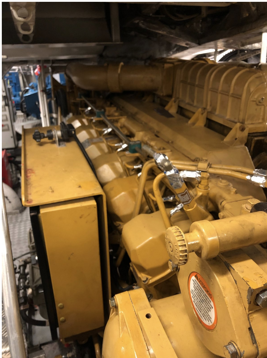
Kuva 25. Yllä mainitut komponentit asennettuna. (Jari Perä 2020)
