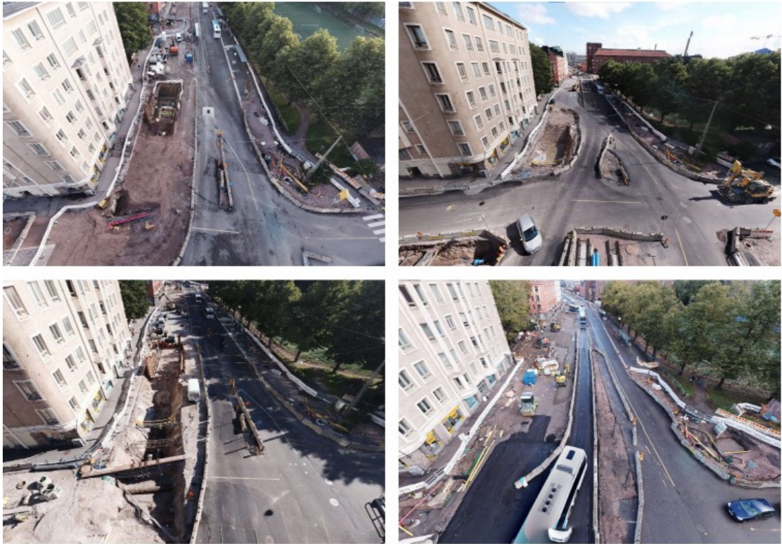
Kuva 14. Työmaan edistys 360°:n ilmakuvina kuukausittain. Heinäkuu – lokakuu.
