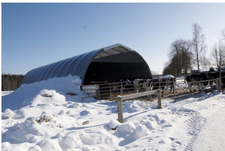
KUVA 5. Vahvarakenteinen kaarihalli (M&T Farm's s.a.)
