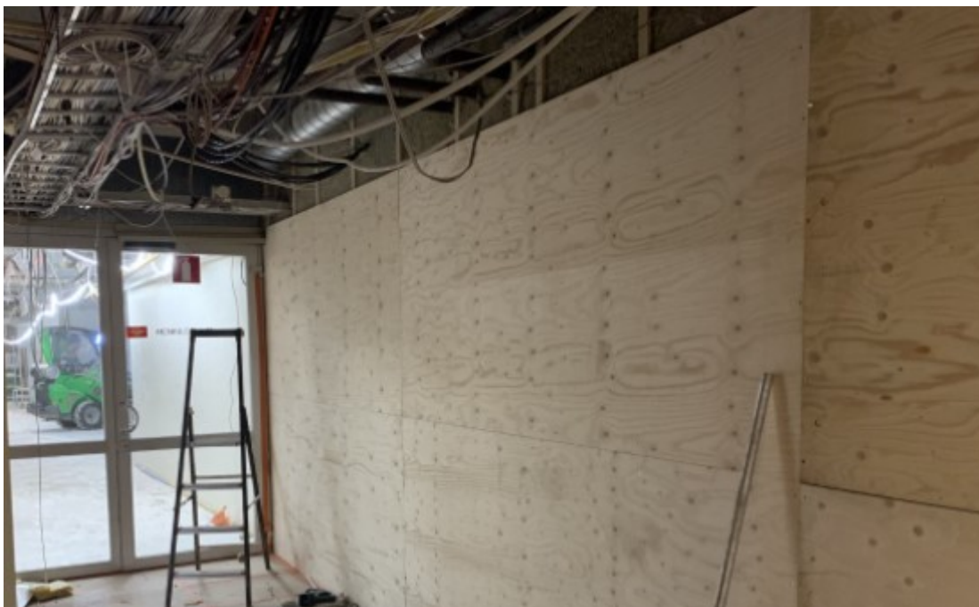
Kuva 3. Työmaalla rakennettu osastointiseinä.
