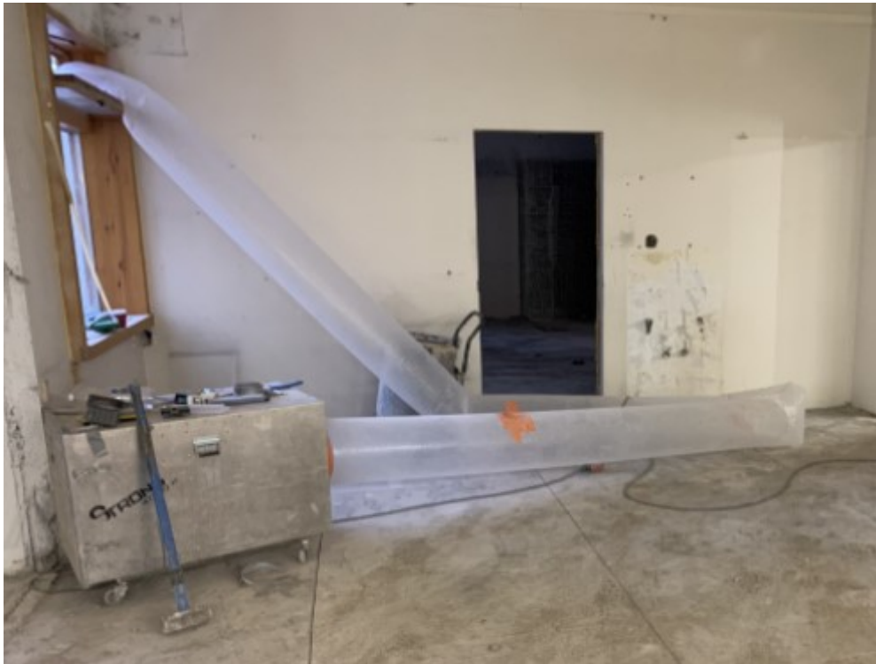
Kuva 5. Alipaineistaja osastoidussa tilassa.
