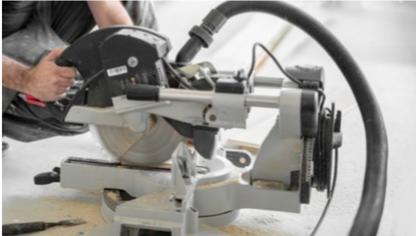
Kuva 2. Sirkkeliin liitetty imuri kohdepoistoksi. (Kohdepoisto rakennustyömaan pölynhallinnassa e-kirja)
