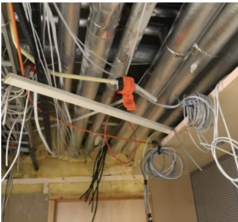
Kuva 4. Työmaalla rakennetun osastointiseinän yläosaa.
