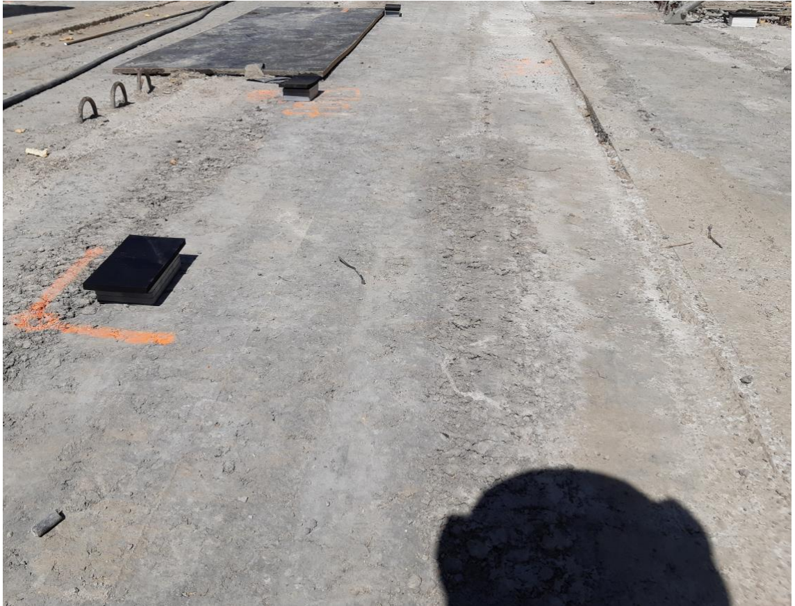
KUVA 4. kuvassa näkyy asennuspalat ja sijainnin merkintä
