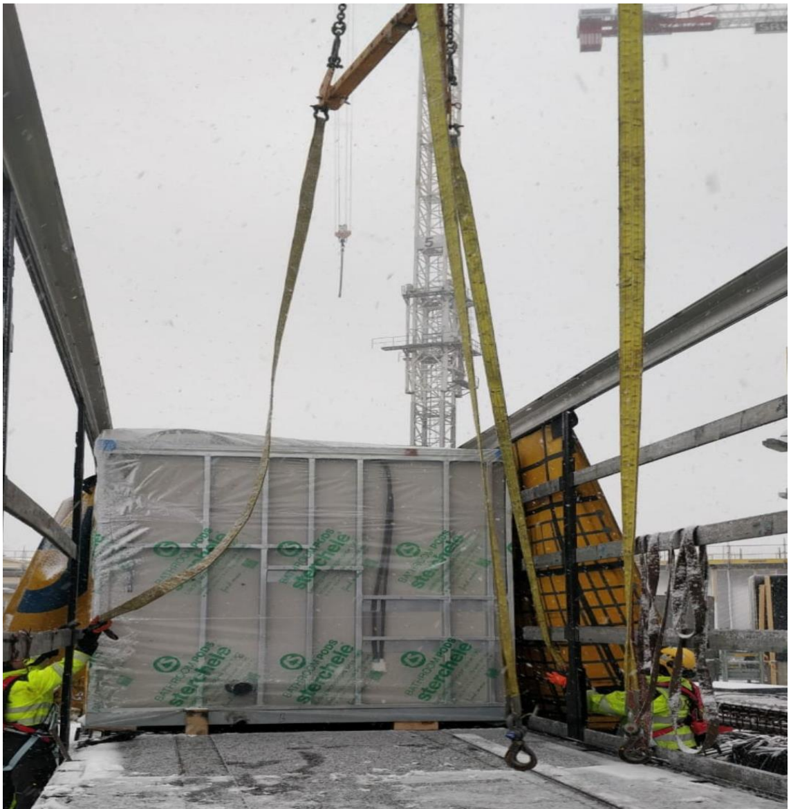
KUVA 5. märkätilaelementin asennus alkamassa
