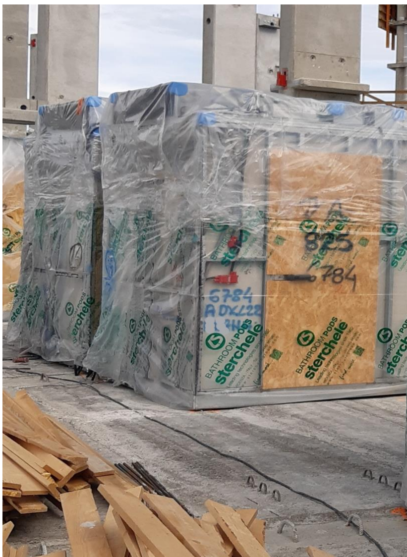
KUVA 8. Elementit asennettuna paikalleen
