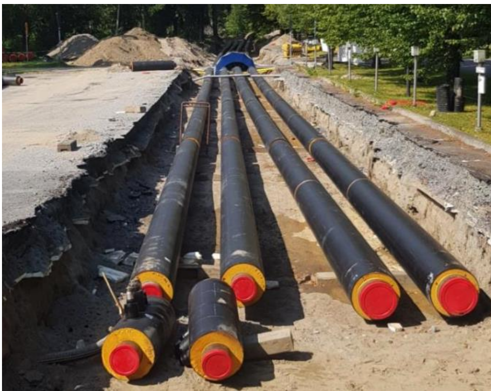
Kuva 7. Kaukojäähdytysverkon asentaminen kaukolämmön yhteisrakentamisessa. Jäähdytysverkon putket ovat kuvassa oikealla ja niiden eristepaksuus on lämmitysverkon putkia ohuempi.
