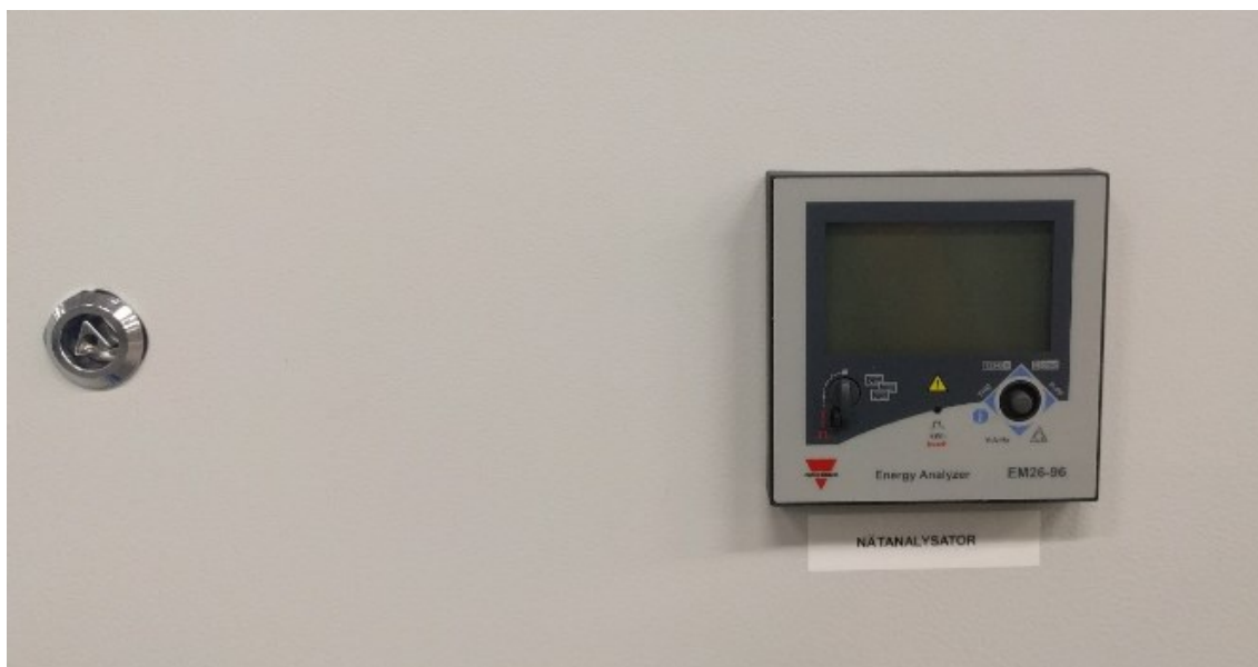
KUVA 4. Verkkoanalysaattori asennettuna keskuksen kanteen (Salminen 2018, 28).
