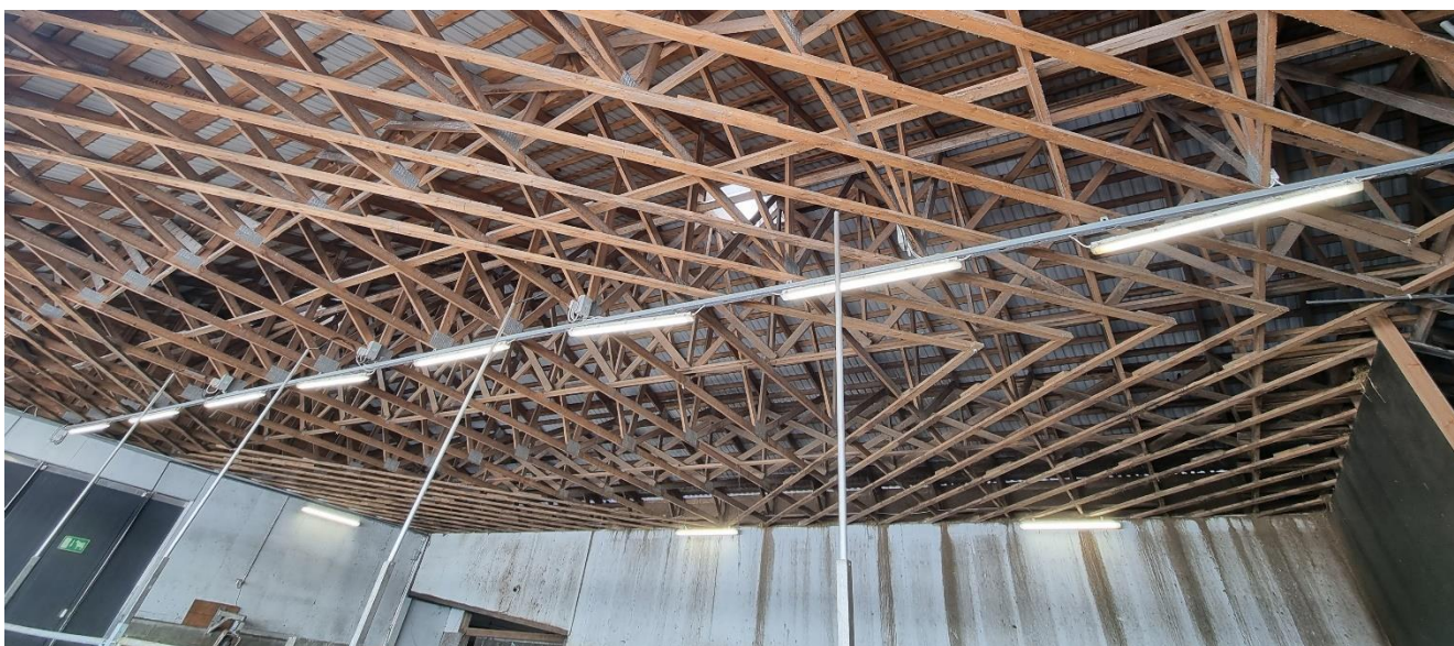
KUVA 2. Yövalaistuksessa käytetyt valaisimet on sijoitettu seinälle.
