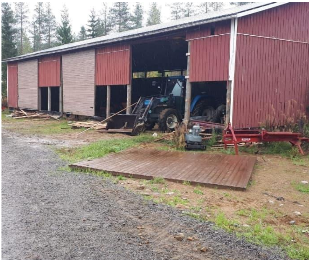
KUVA 2. Konehalli ennen muutostöitä (Vinkki 2018-09-15)
