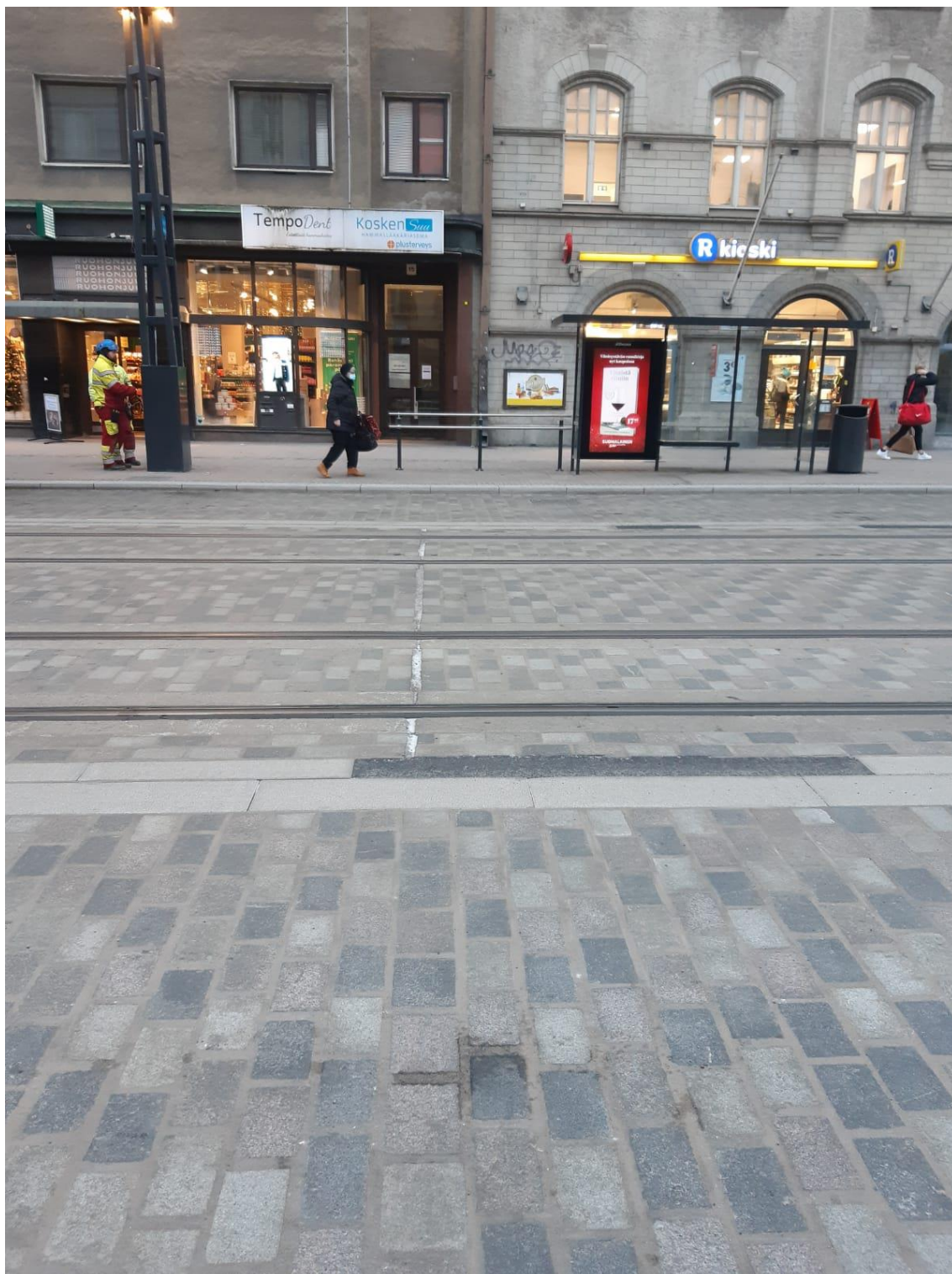
KUVA 4. Rikkoutuneiden reunakivien koloihin lisätty öljysoraa. (Juuso Aaltonen 2020)
