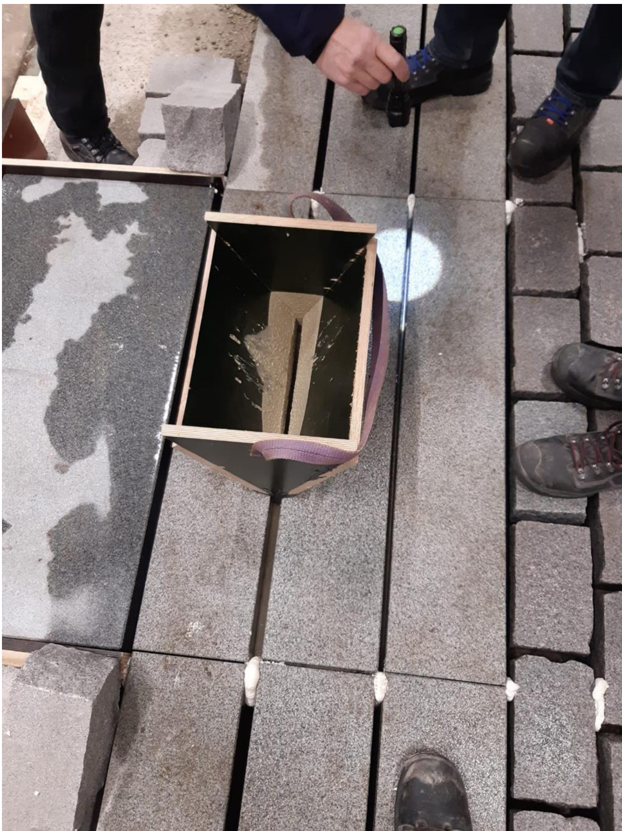
KUVA 8. Kivien saumojen juotoksiin käytettävä suppilo (Juuso Aaltonen 2021)
