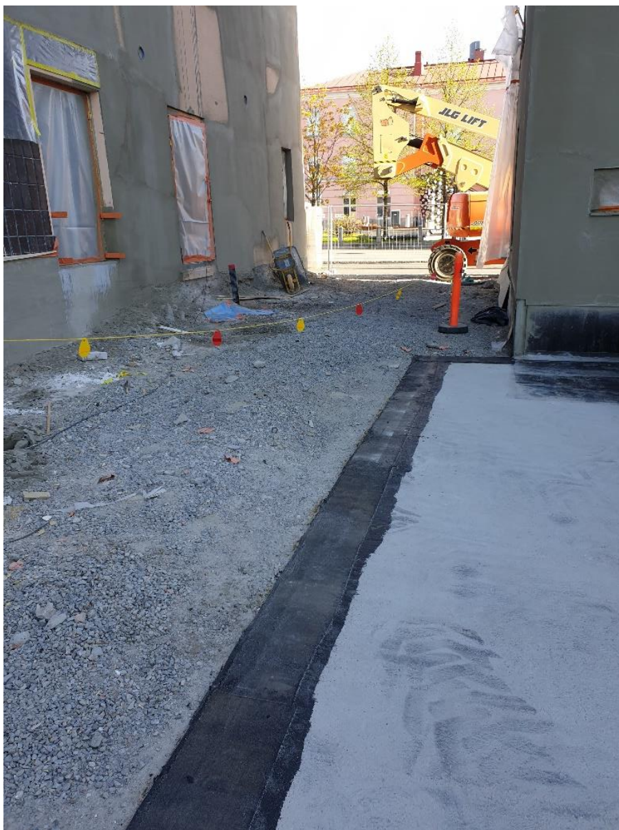
KUVA 10. Maanpaineseinän bitumihuopaylösnoisto (Kuparinen 2020)
