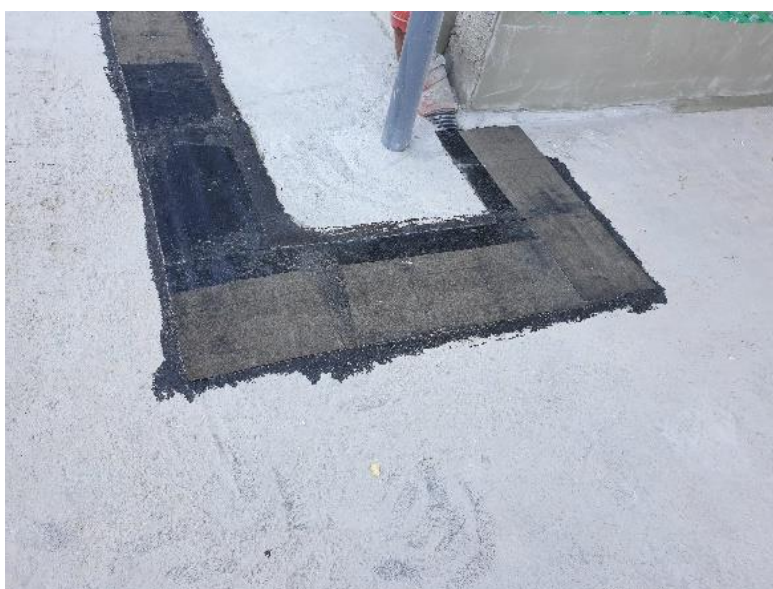
KUVA 9. Bitumihuovalla vahvistettu liikuntasauma (Kuparinen 2020)
