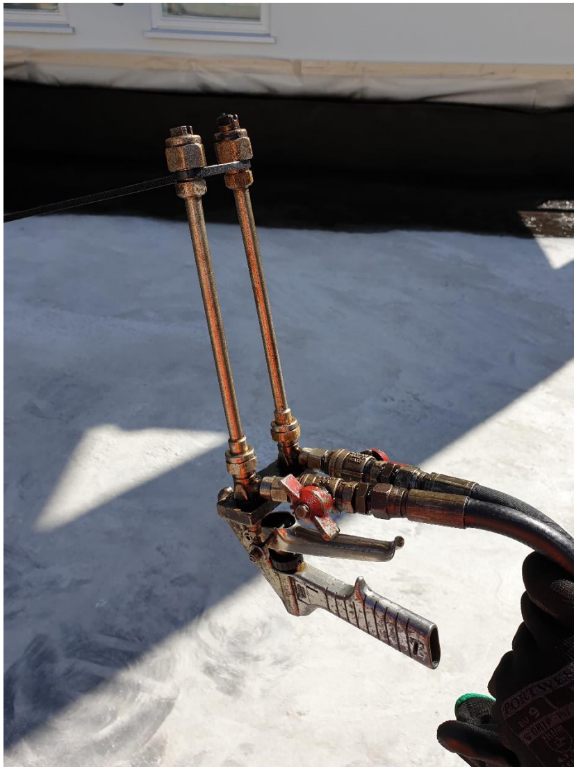
KUVA 15. Ruiskukumin asennukseen käytettävä suutin yhdistelmä. (Kuparinen 2020)
