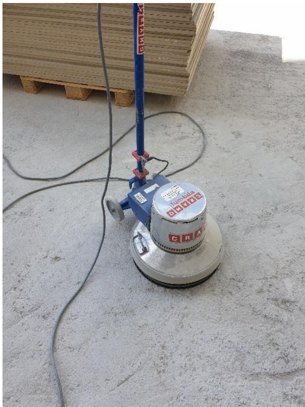
KUVA 11. Lattiahiomakone jolla pihakansi hiottiin enne ruiskukumin asennusta. (Kuparinen 2020)
