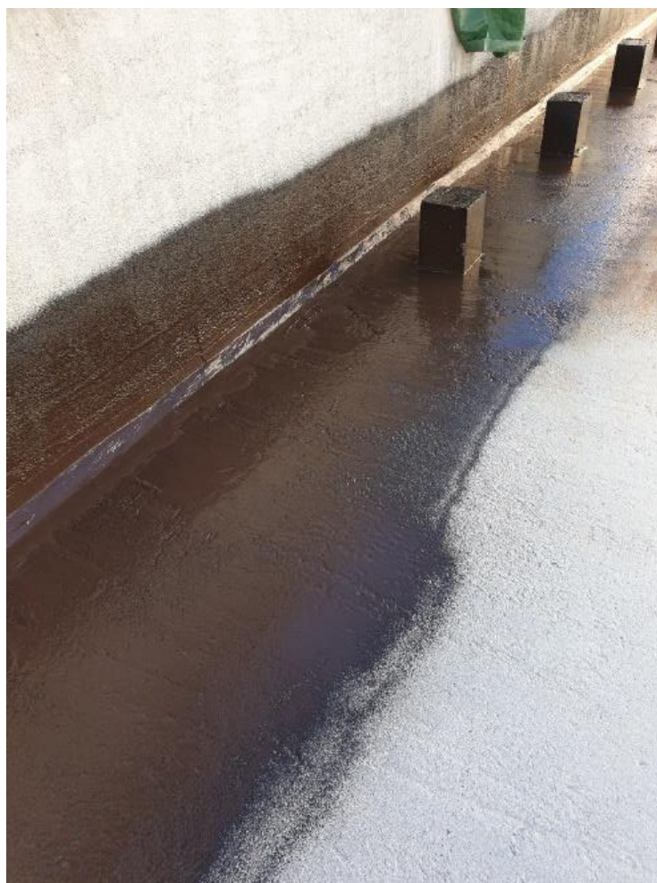
KUVA 6. Ruiskukumilla tehty ylösnosto sekä pihavarusteiden perustusten vedeneristystä (Kuparinen 2020)
