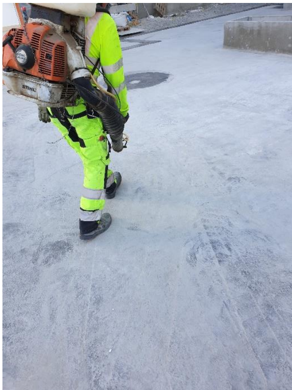
KUVA 12. Pihakannen kevytpuhdistus juuri ennen kumiasennuksen aloittamista. (Kuparinen 2020)
