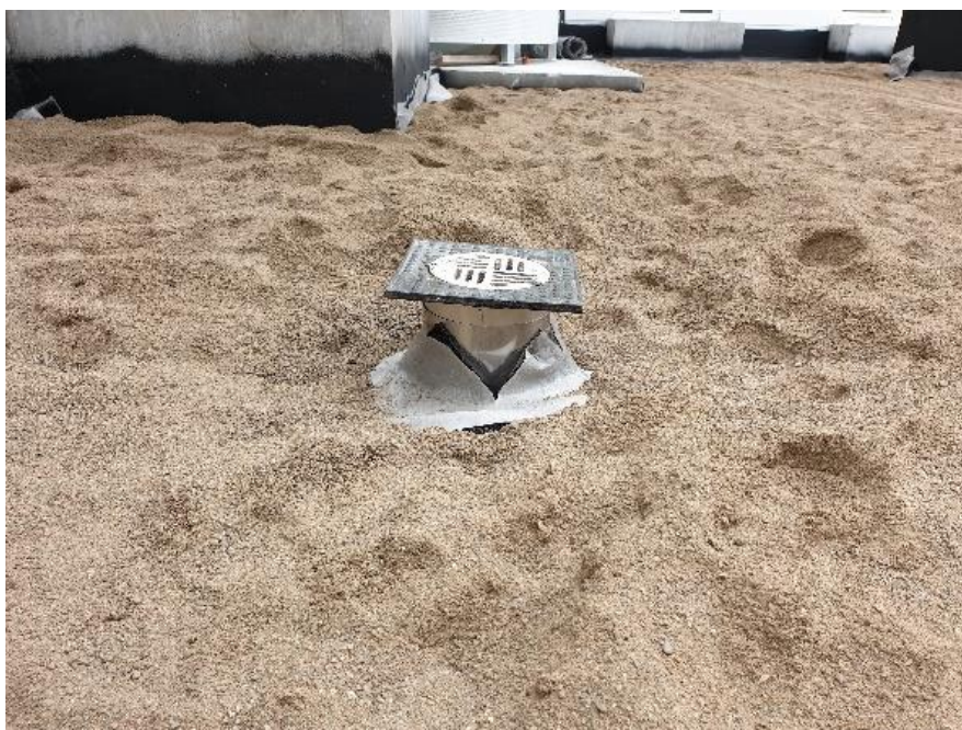
KUVA 2. Ruiskukumin päälle asennettu Enkadrain-salaojamatto ja asennushiekka (Kuparinen 2020)
