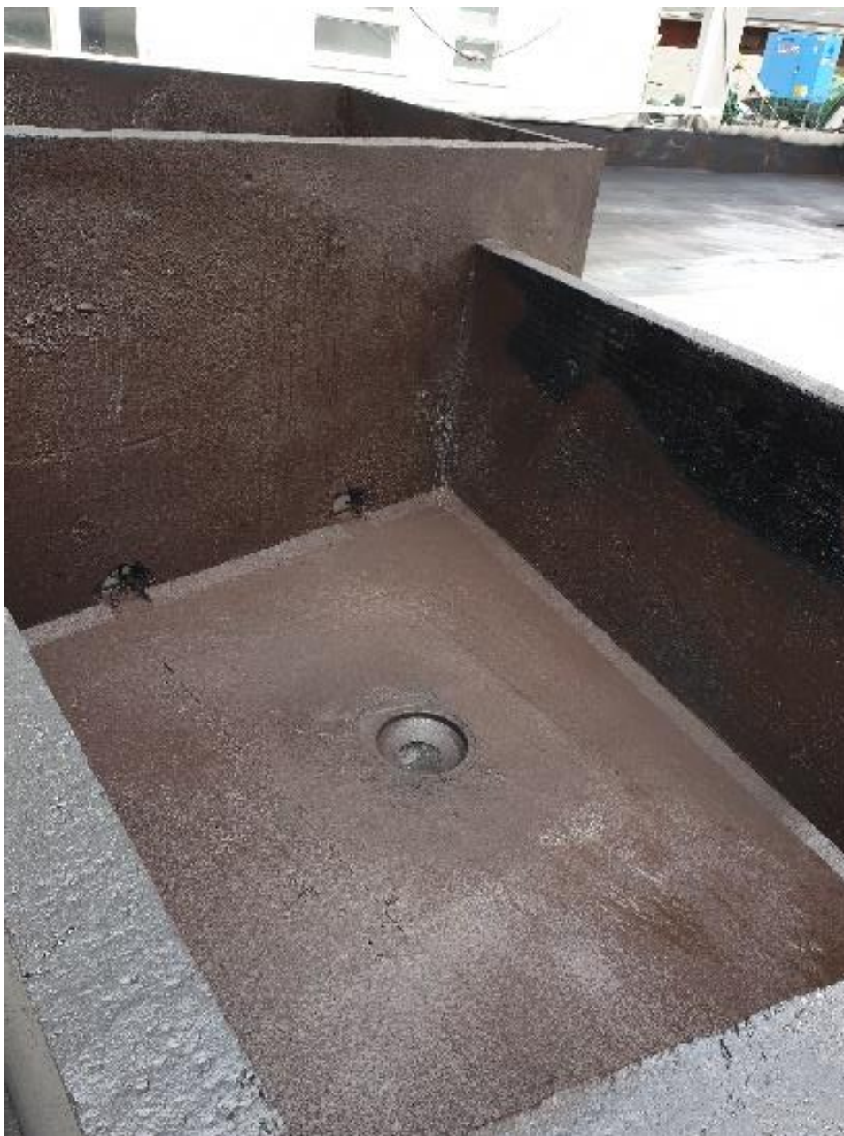
KUVA 7. Istutusallas ruiskukumilla vesieristettynä (Kuparinen 2020)
