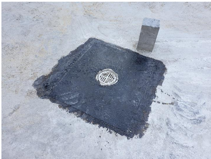
KUVA 5. Pihakannen sadevesikaivo, laipan päälle asennettu bitumihuopa varmistamaan vedenpitävyyttä (Kuparinen 2020)
