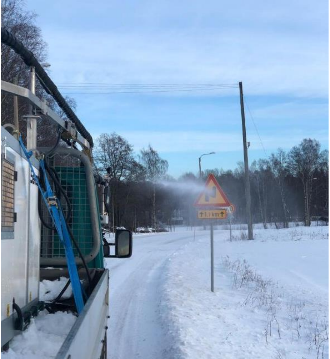
Kuva 6. Painepesurilla liikennemerkkin puhdistusta (Serco Oy 2021)
