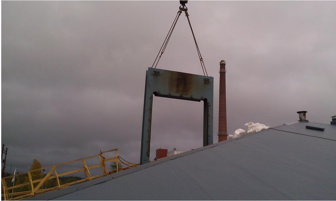
Kuva 3. Kappaleet nostettiin kattoon tehdystä aukosta ulos nosturilla
