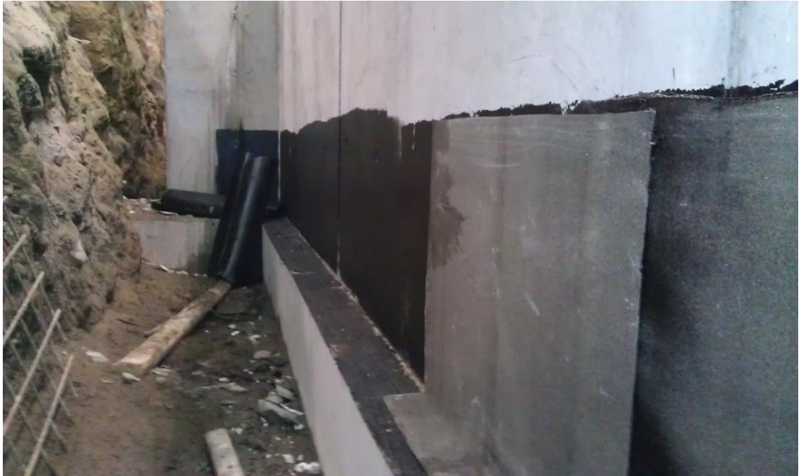
Kuva 8. Bitumiliuos sivelty tartunnaksi ja bitumikermiä asennettuna
