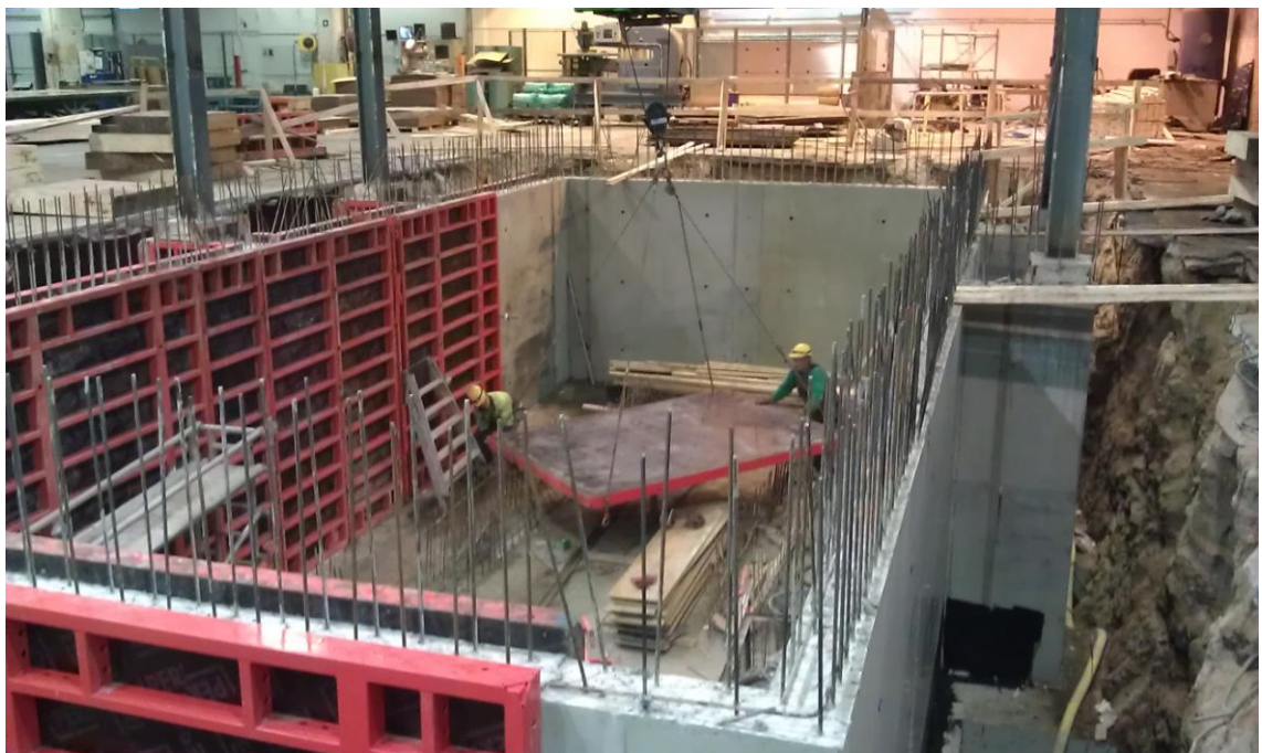
Kuva 10. Järjestelmämuottien purkamista kurottajan avulla
