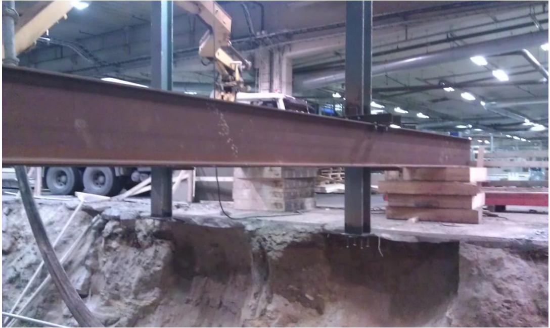
Kuva 4. Molemmat HEB-vahvistuspalkit asennettuina
