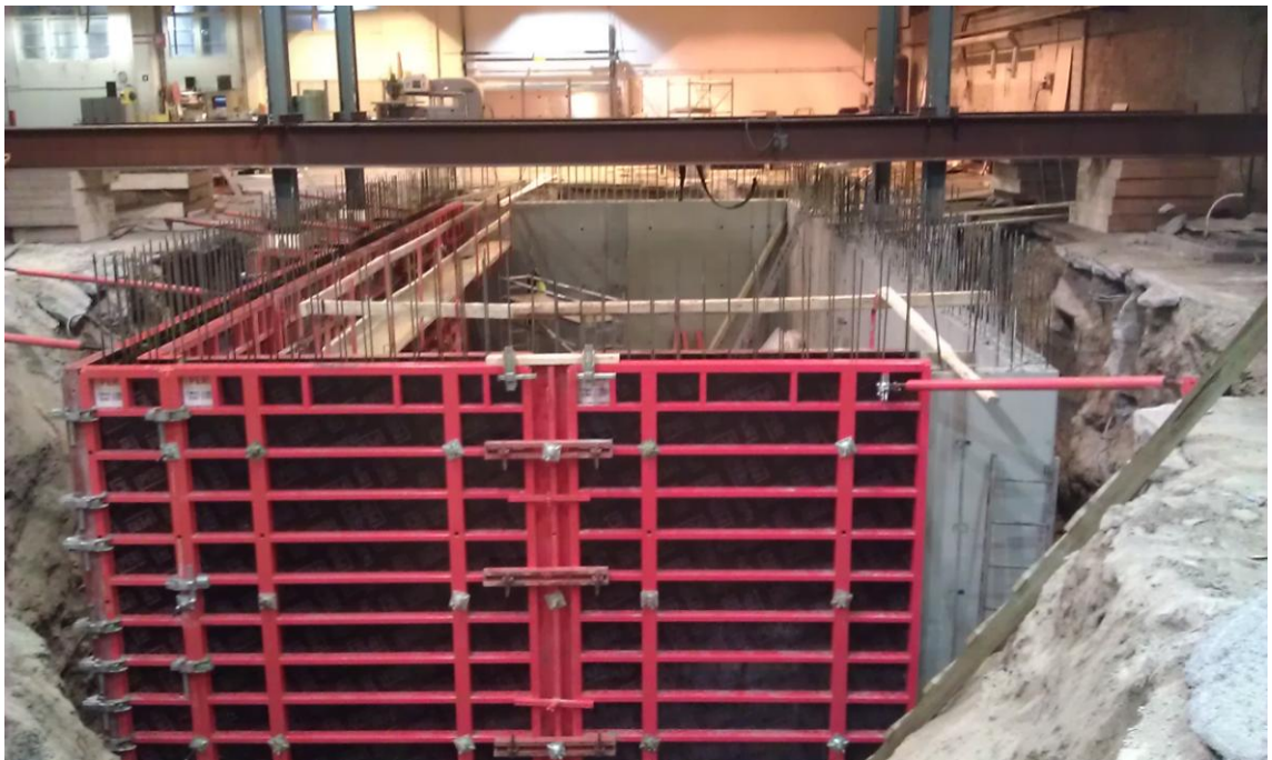
Kuva 7. Ensimmäinen puolikas seinästä valettu, jälkimmäinen raudoitettu ja muotitettu
