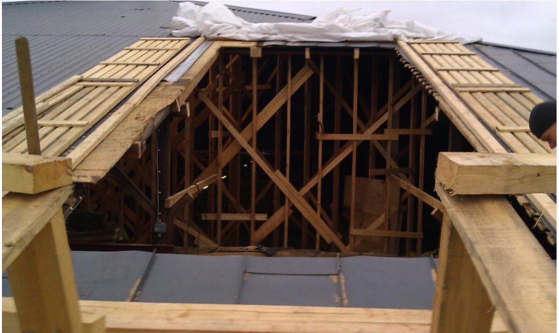
Kuva 1. Tehtaan vesikatto jouduttiin avaamaan nostotehtäviä varten
