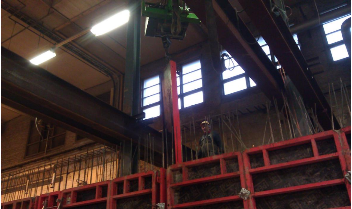
Kuva 9. Rakennuksen mataluus vaikeutti etenkin muottien siirtelyä
