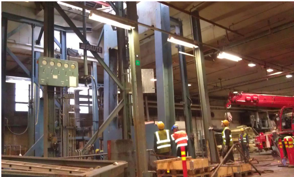
Kuva 2. Vanha pinnoitepuristin purettiin kappaleiksi tehtaan sisällä
