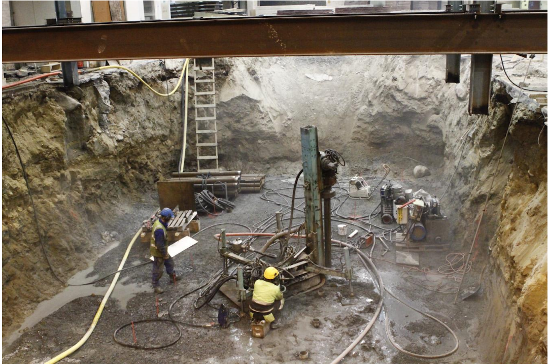
Kuva 14. Porapaalutus käynnissä
