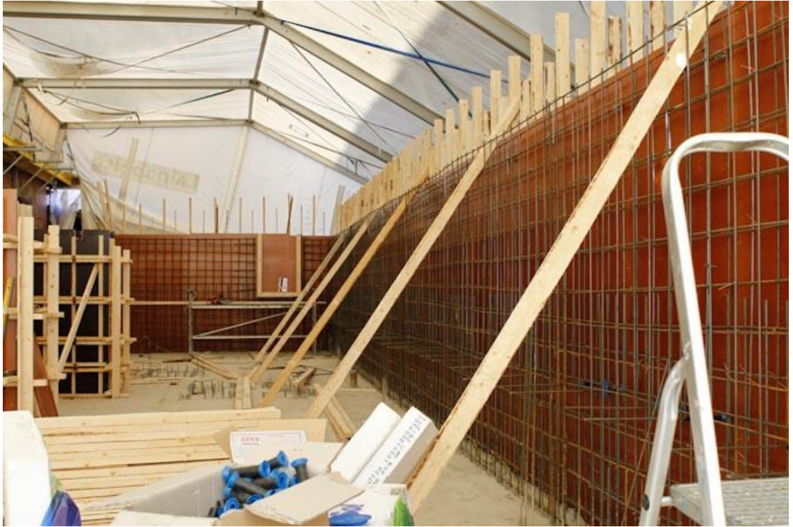
Kuva 11. Puutavarasta tehty seinämuotti keskeneräisenä (Kymecon Oy 2012)
