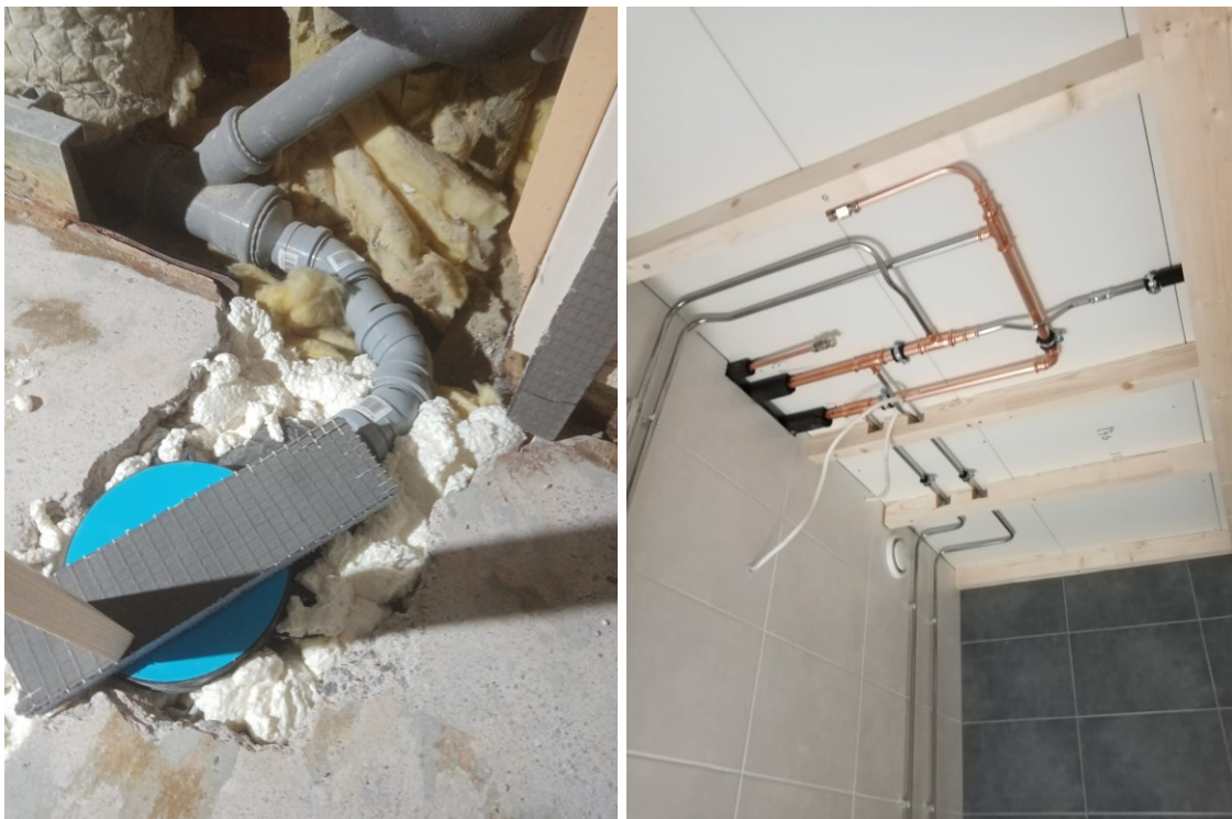
KUVA 9 ja 10. Uusien LVI-viemärijärjestelmien lattia asennusta sekä käyttövesilinjojen asennusta katon välitilaan.
