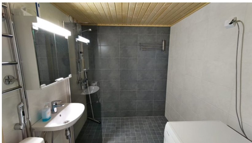
KUVA 11. Valmista saniteettitilaa kalusteineen ja pintoineen.
