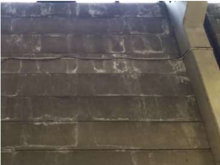
Kuva 2. Ulkoseinän kosteusvaurio. (Kaikkonen 2021.)
