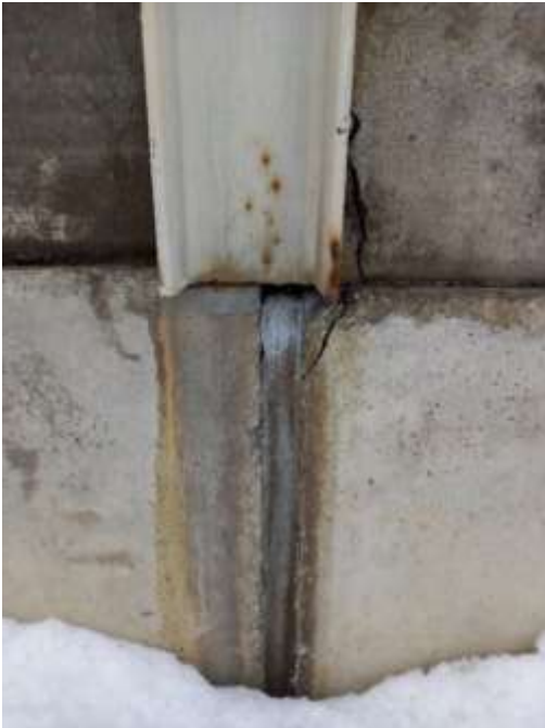
Kuva 3. Sokkeli ja ulkoseinän liittymien vauriot. (Kaikkonen 2021.)
