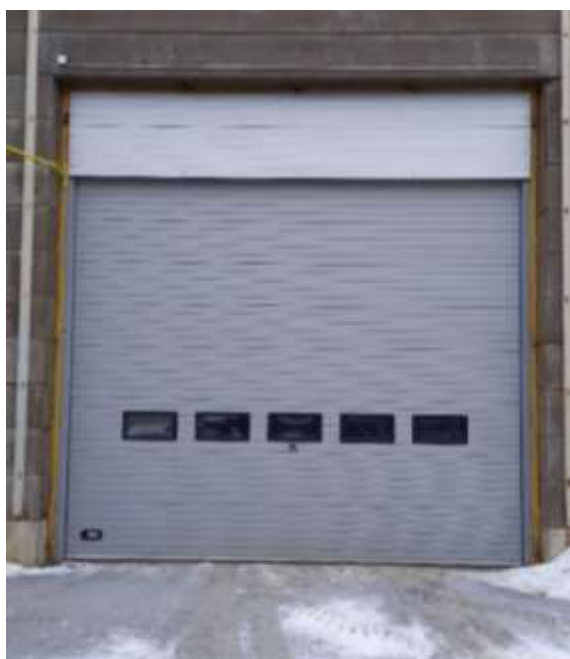
Kuva 7. Rakennuksen uusittu nosto-ovi U-arvo 1,20 W/m 2 K. (Kaikkonen 2021.)
