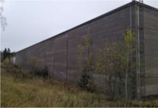
Kuva 4. Runsasta kasvustoa rakennuksen seinustalla. (Kaikkonen 2021.)
