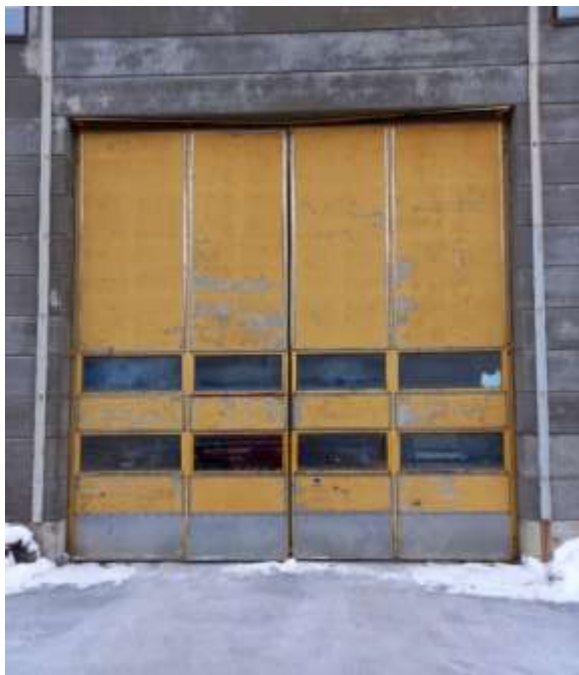
Kuva 6. Rakennuksen alkuperäinen taitto-ovi U-arvo (?)W/m 2 K. (Kaikkonen 2021.)
