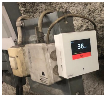
Kuva 6 Siemens QSA2700D PM 2,5 -sensori.
