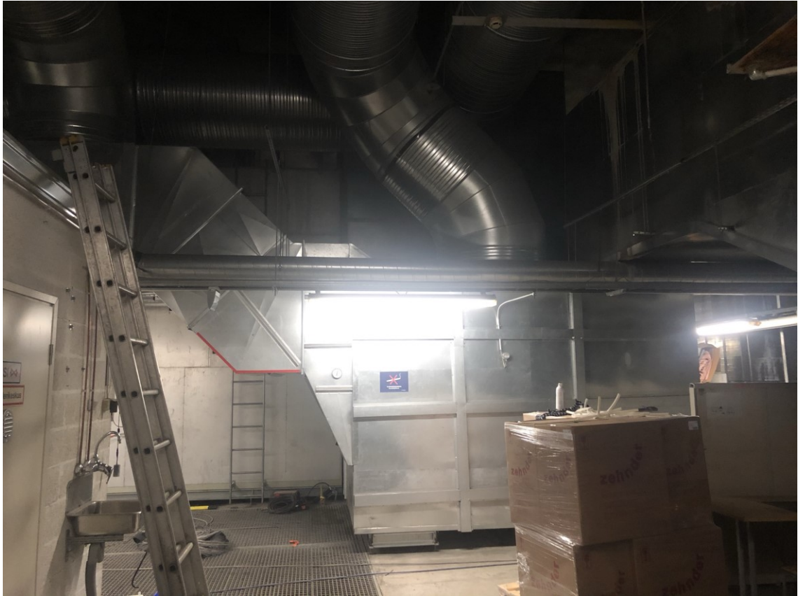
Kuva 12 Ilmanvaihtokone TK 201.
