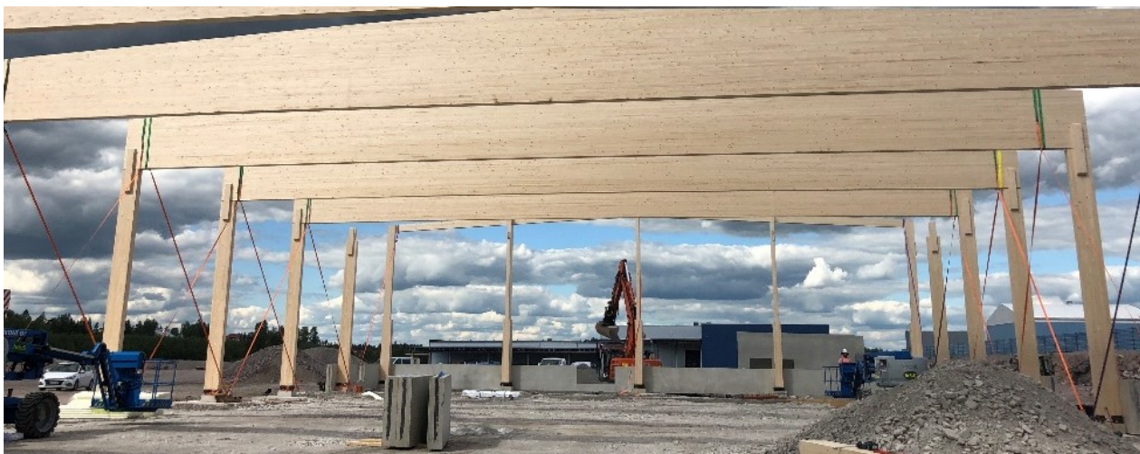
Kuva 18. Koy Tivolimäki, rungon työaikainen tuenta. (Kuva Rebecca Koivukoski 15.7.2020)
