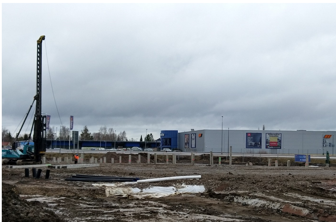
Kuva 5. Koy Järvenpään Helmi työmaa. Teräsbetonipaalutus. (Kuva: Antti Vesilahti 18.3.2020)
