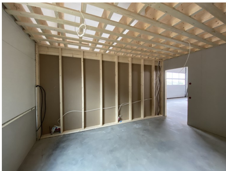
Kuva 8. Väliseinärunko kertopuusta, tekniikka asennettu. (Kuva: Rebecca Koivukoski 10.9.2020)
