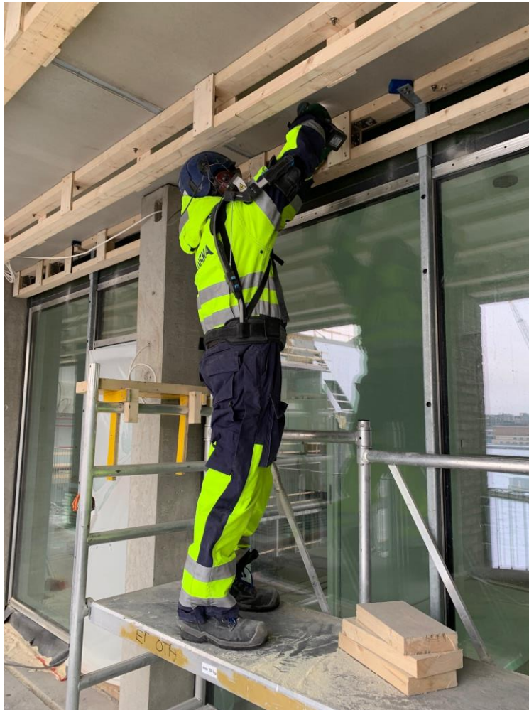
Kuva 10. Skelex käytössä parvekkeiden alakattotöissä.
