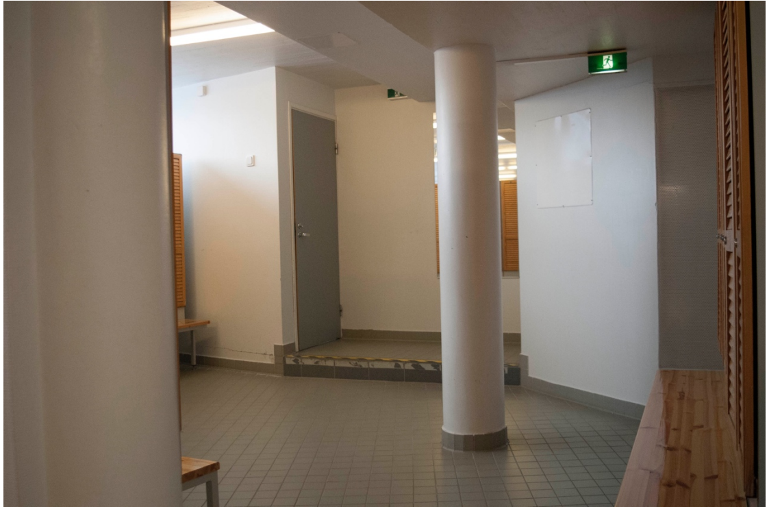
Kuva 19. Urheilupuiston uimahallin miesten pukuhuoneen sisääntulo (Pylkkänen 2021)
