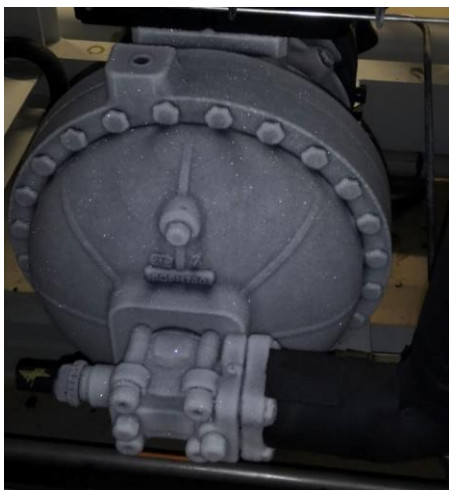
KUVA 2. Kompressoriin joutuvat pisarat
