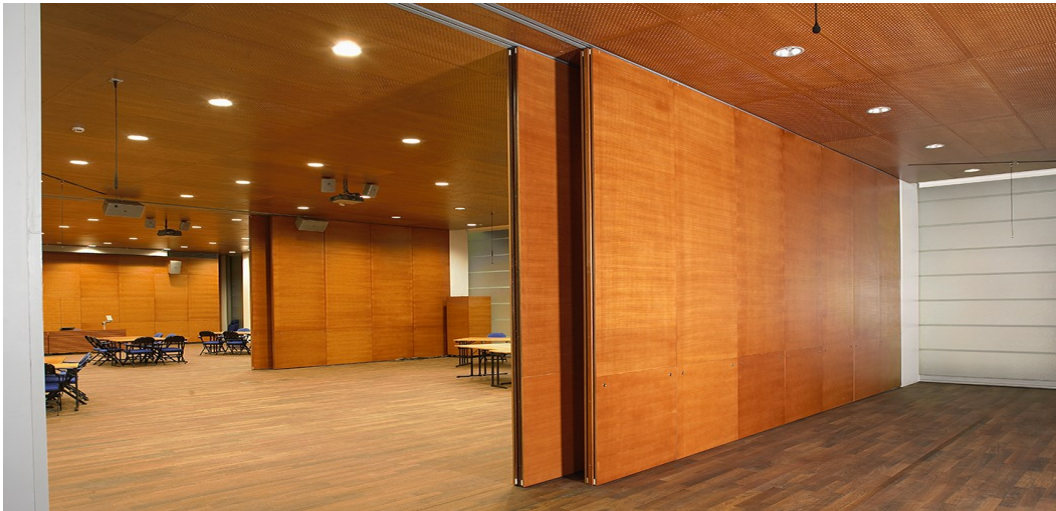
Kuva 4: Kohteessa oleva valmis siirtoseinä(t).
