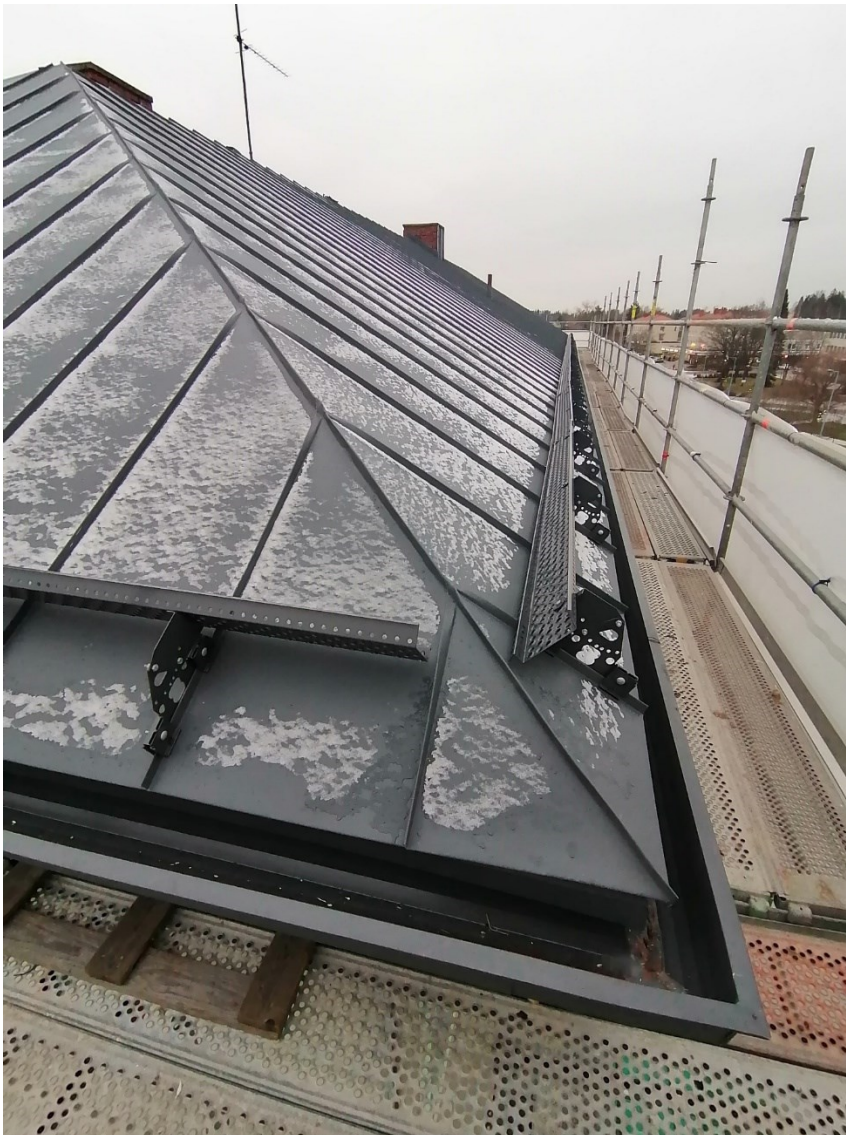
Kuva 10 Konesaumattu peltikatto (Henri Helén, 2020)
