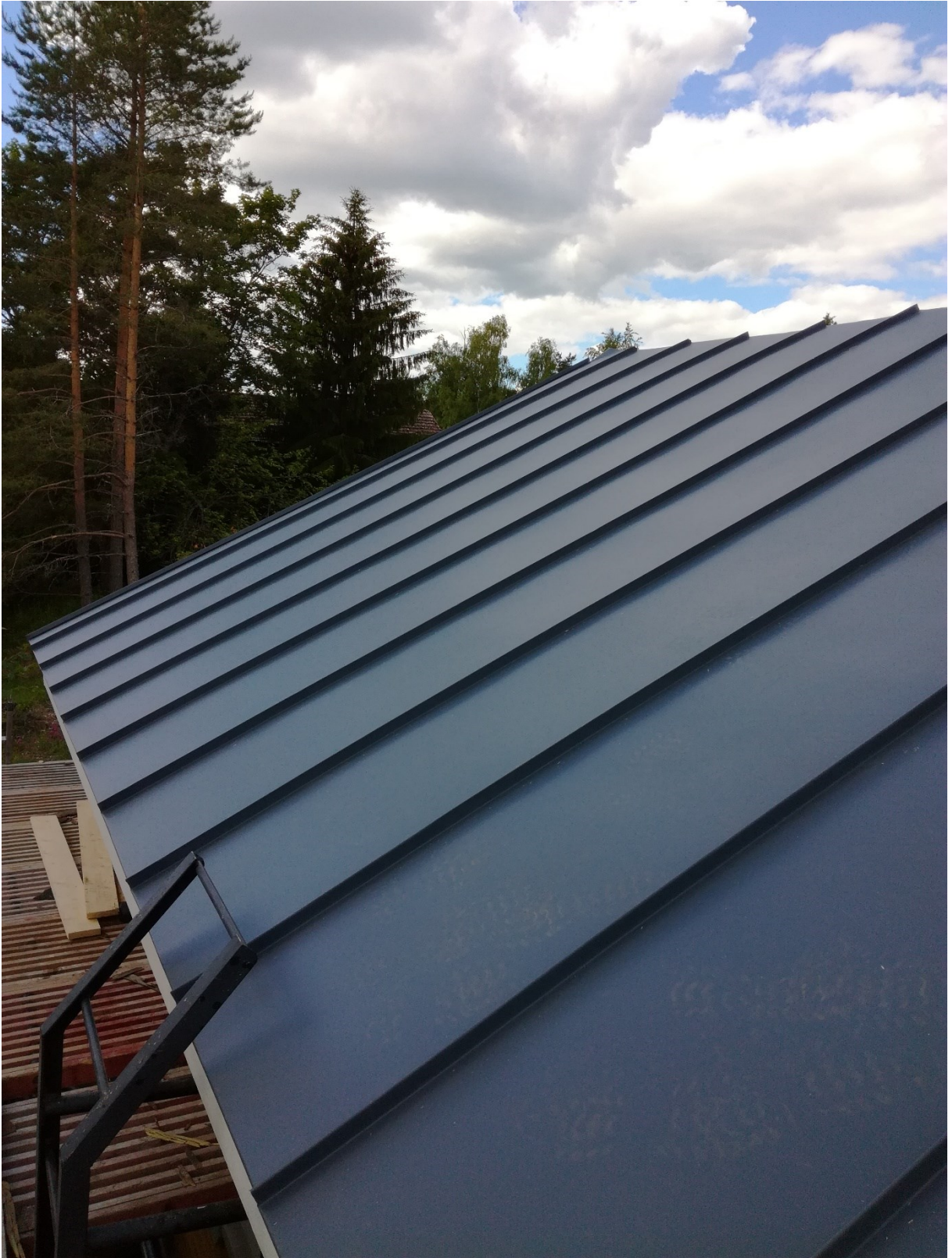
Kuva 14 Konesaumakaton rivit levitettynä (Henri Helén, 2016)
