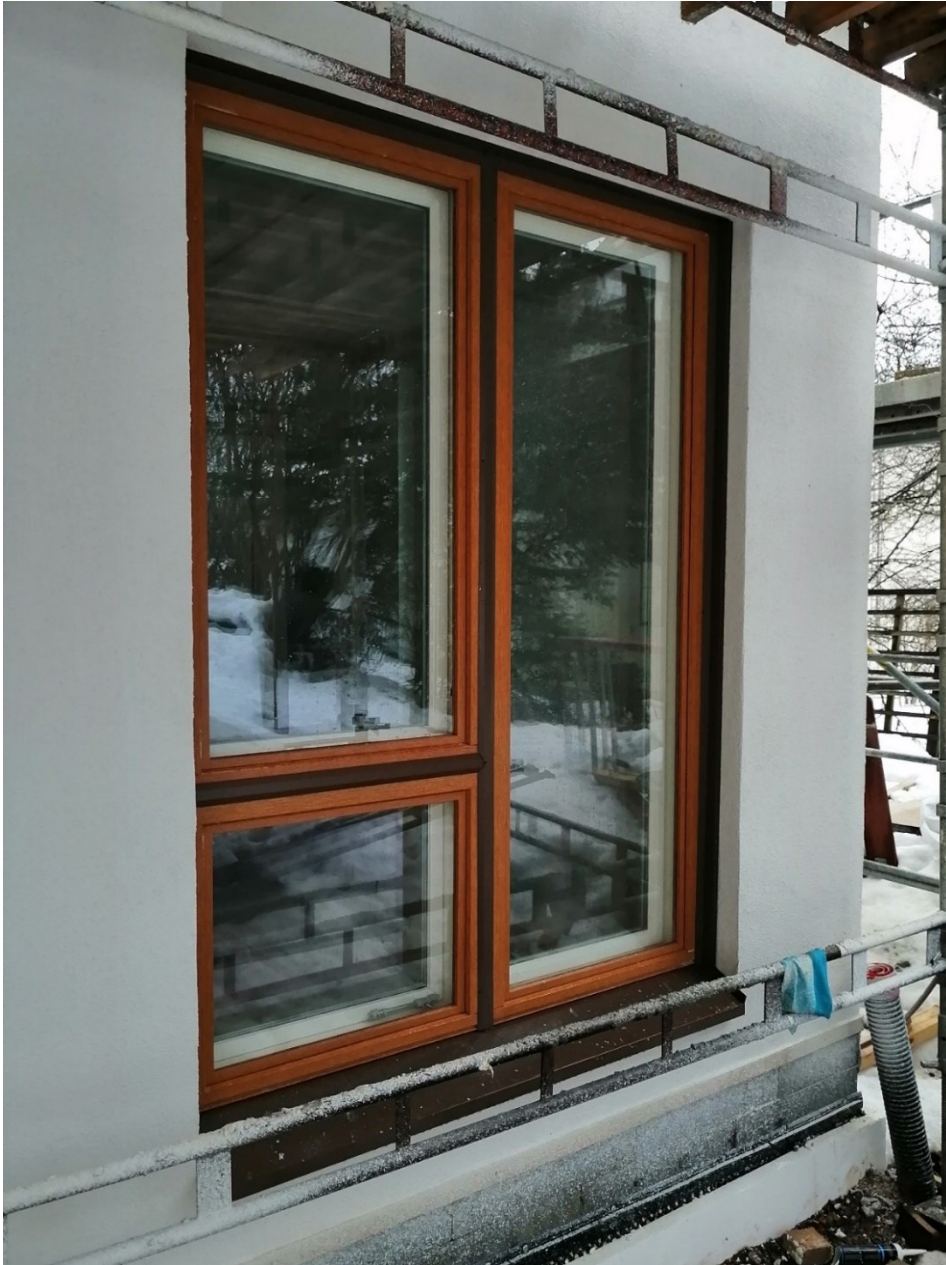
Kuva 21 Vesipellitys ja listoitus (Henri Helén, 2020)
