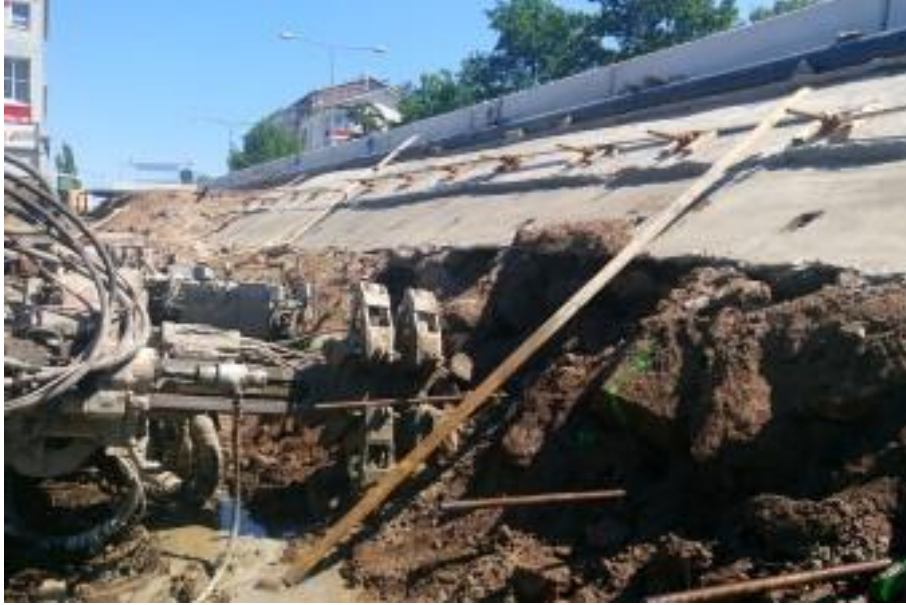
Kuva 8. Kaivantoluiskan vahvistaminen maanaulauksella (Insinööritoimisto X)
