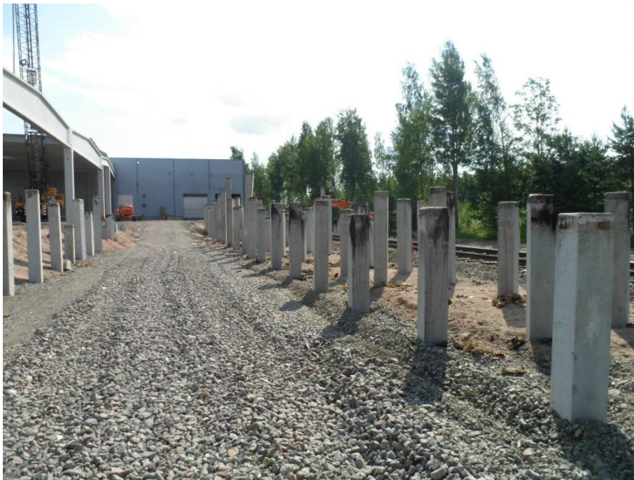
Kuva 9. Perustusten tekeminen teräsbetonisilla lyöntipaaluilla (Insinööritoimisto X)
