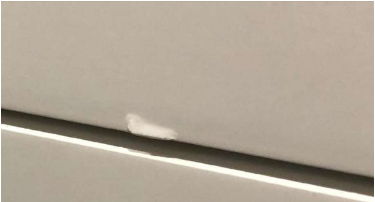
Kuva 12. Kalusteen etusarjan vaurio
