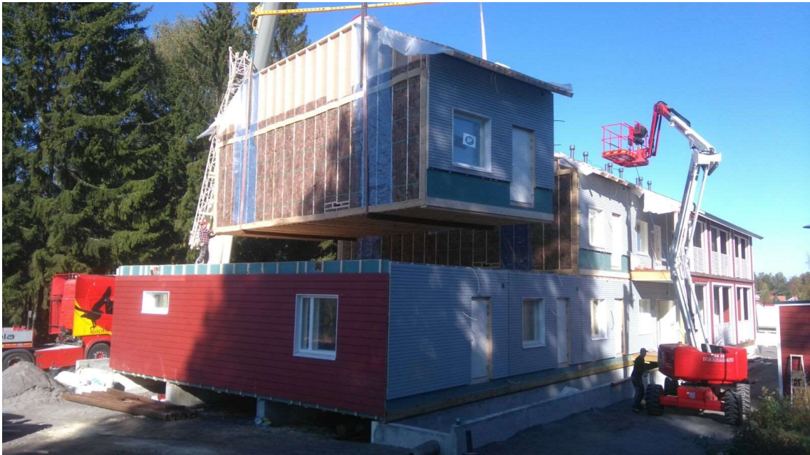
KUVA 3. Tilaelementin asennusta
