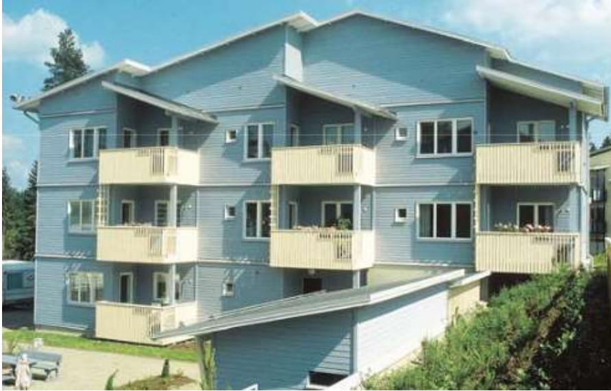
KUVA 2. Koerakentamishankkeena tehty ensimmäinen puukerrostalo (9)
