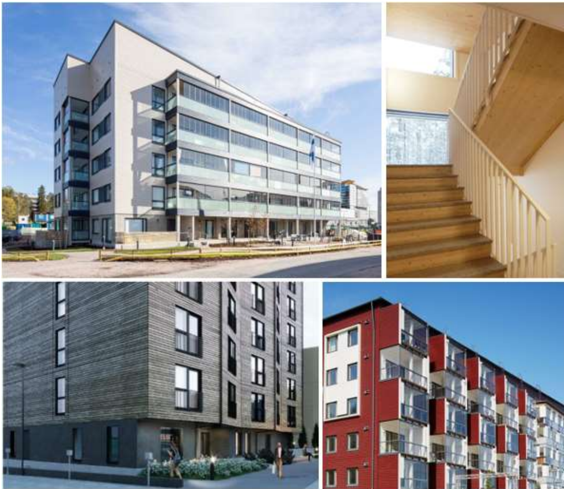
KUVA 1. Puukerrostaloja puisella ulkoverhouksella (2)
