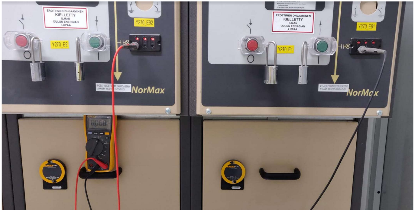
KUVA 18. Vaiheistuksen mittaus
