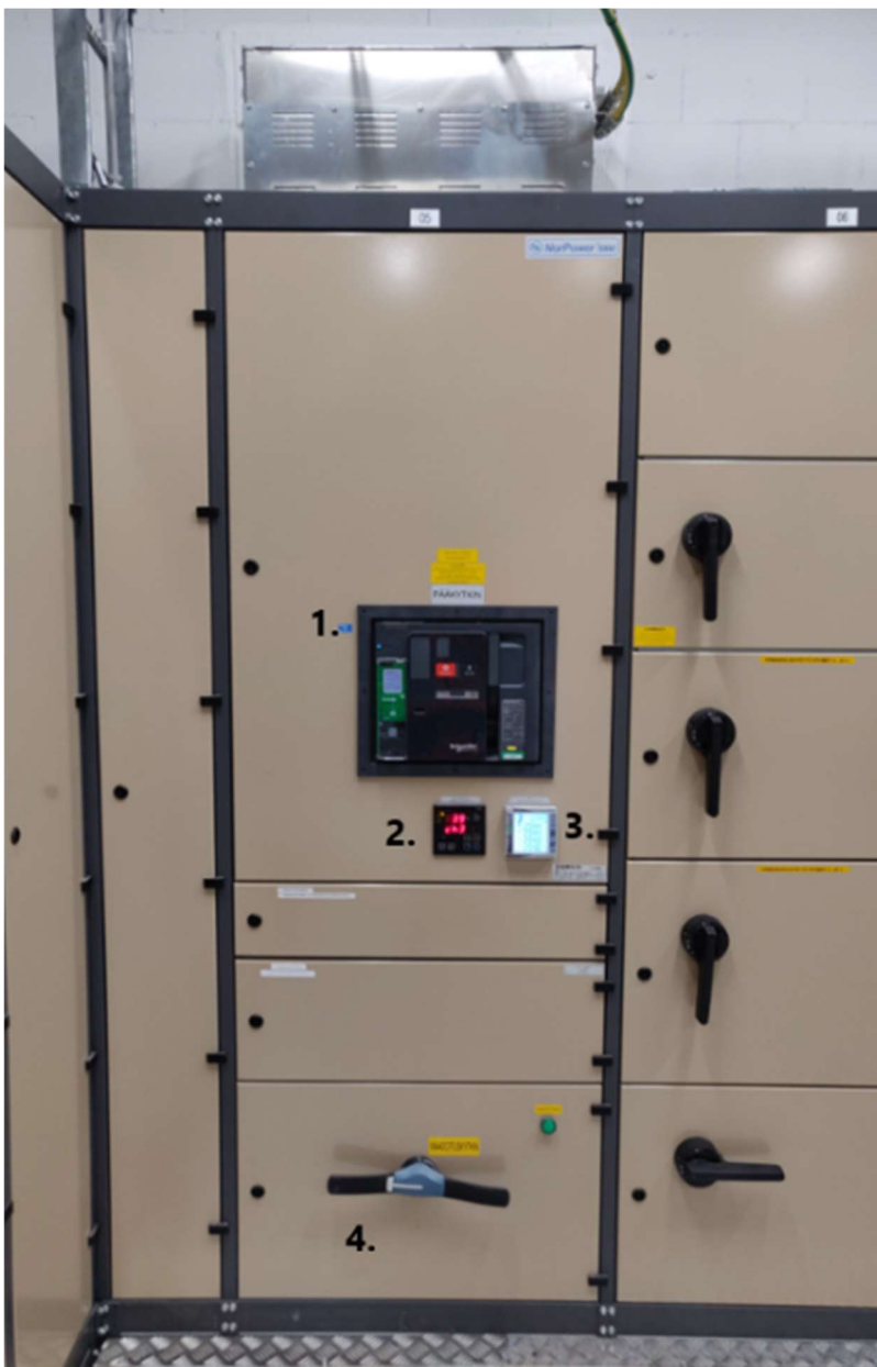
KUVA 14. Pääkeskuksen syöttökenttä
