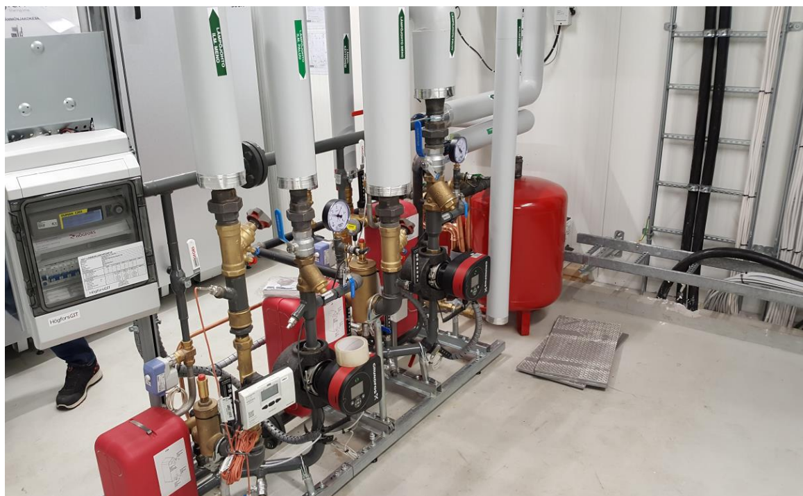
KUVA 3. Tyypillinen 3-piirinen kaukolämmön alajakokeskus (Nieminen 2020)
