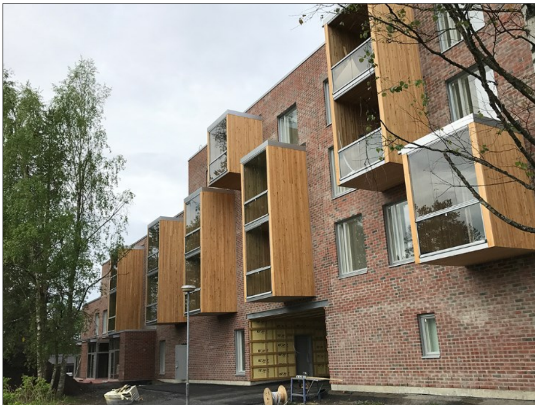
KUVA 2. Woodia-ripustettava CLT-elementtiparveke (PuuIdea 2017)
