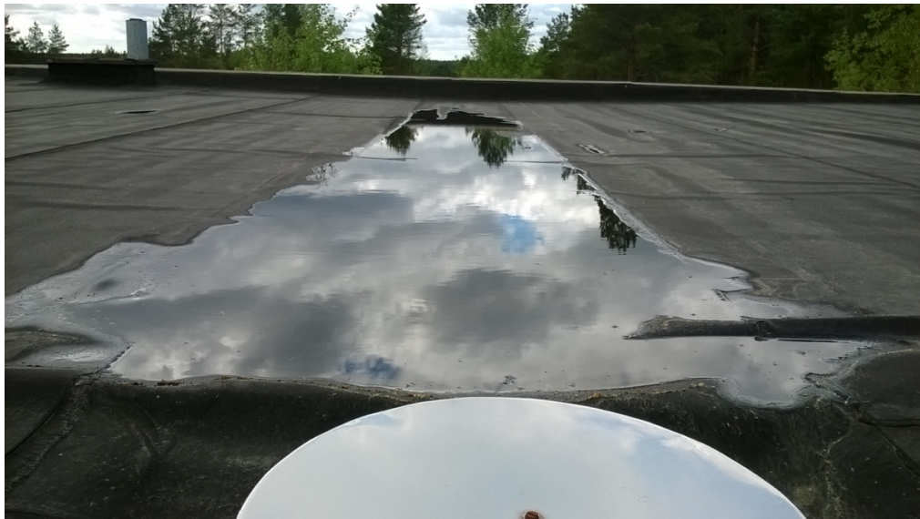
Kuva 13. Vesikaton kuntoluokituksessa otetaan vesikaton osat yksityiskohtaisesti huomioon
