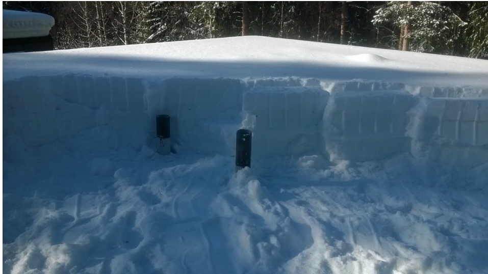
Kuva 11. Lumimassat voivat tukkia esimerkiksi viemärin tuuletusputket kokonaan [7.]
