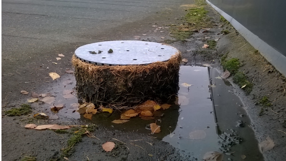
Kuva 12. Kattokaivojen puhdistus on yksi kesäkauden tärkeimmistä huoltotöistä
