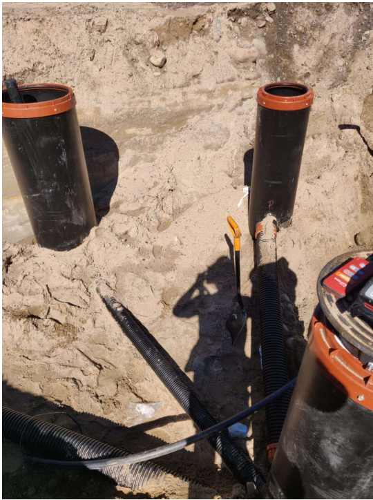
KUVA 2 Ulkopuolisten viemärien valokuvaus (AHS Tekniikka Oy)
