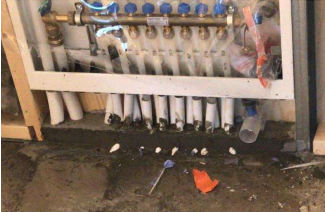
KUVA 4 Lattialämmityspotket jakotukissa valettuna
