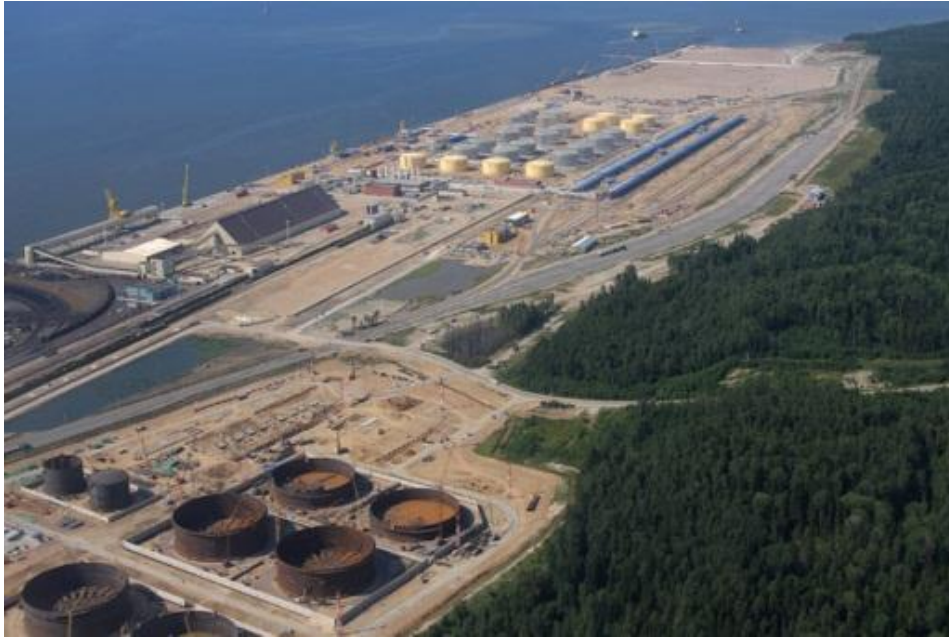
Kuva 7: Ust-Lugan öljyterminaali rakennusvaiheessa (Ust-Luga Company, 2009).
