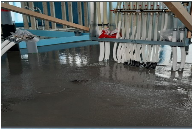
KUVA 6. Lasikuituverkko noussut valun pintaan
