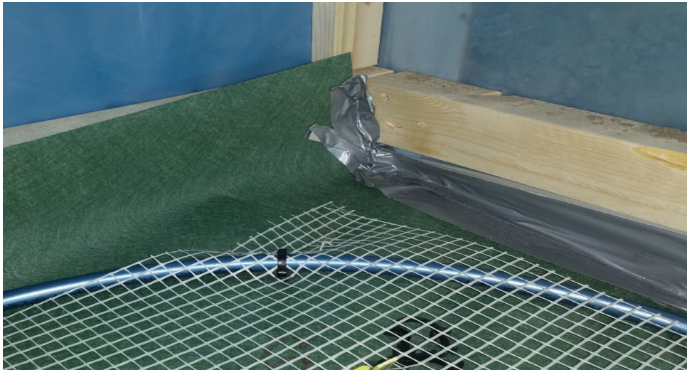
KUVA 9. Erotuskangas teipattuna nurkassa
