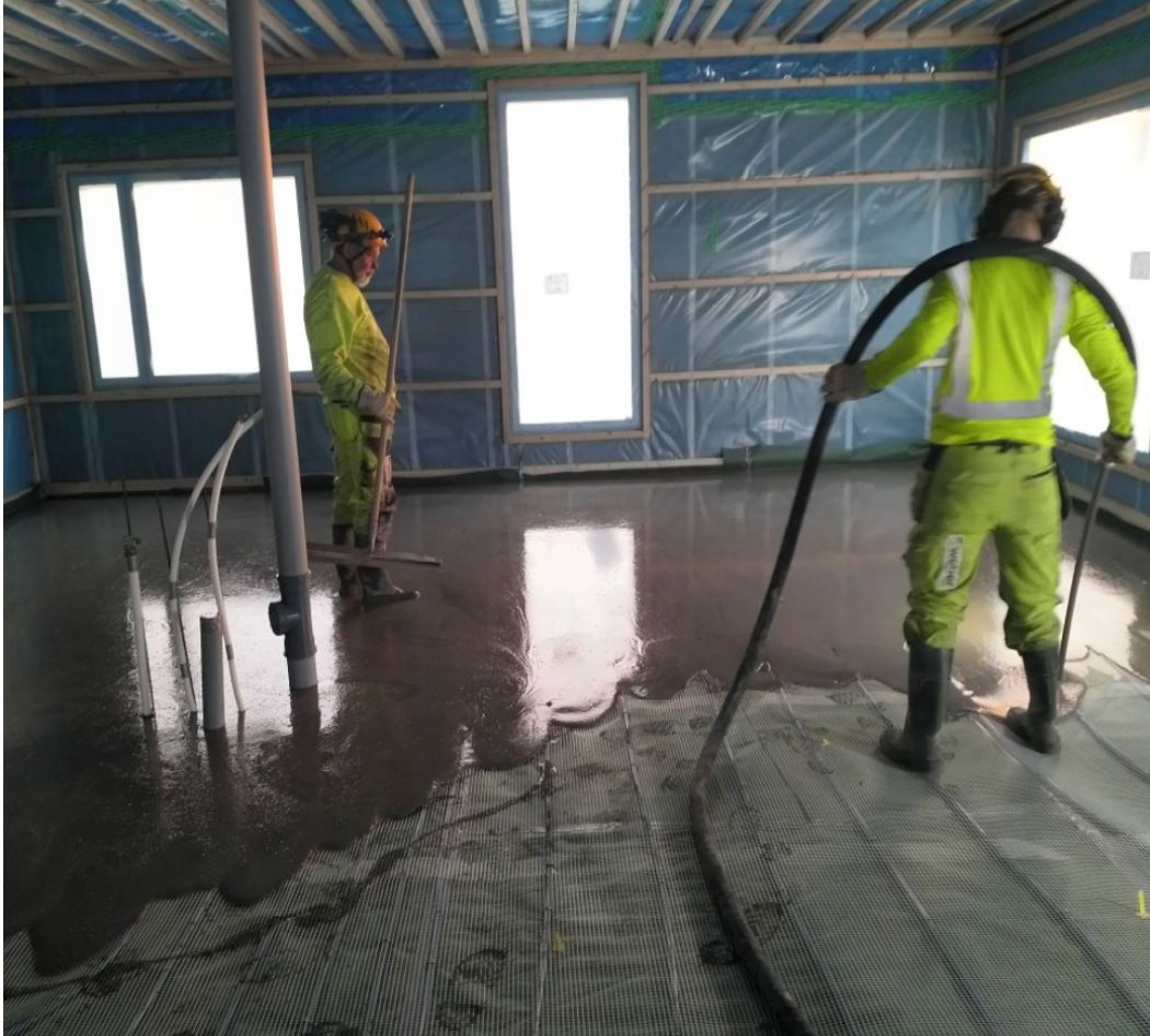
KUVA 17. Plaanomassan levitystä ja pinnan tasoitusta
