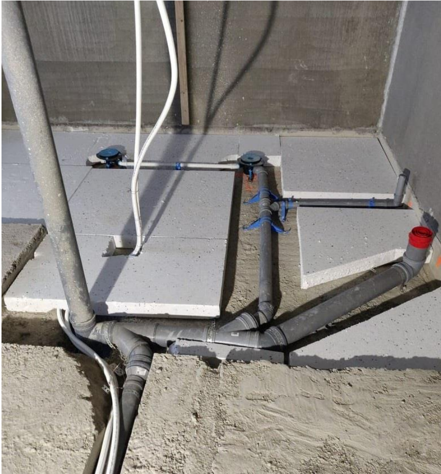
KUVA 7. Huoneiston viemärit toteutettuna.
