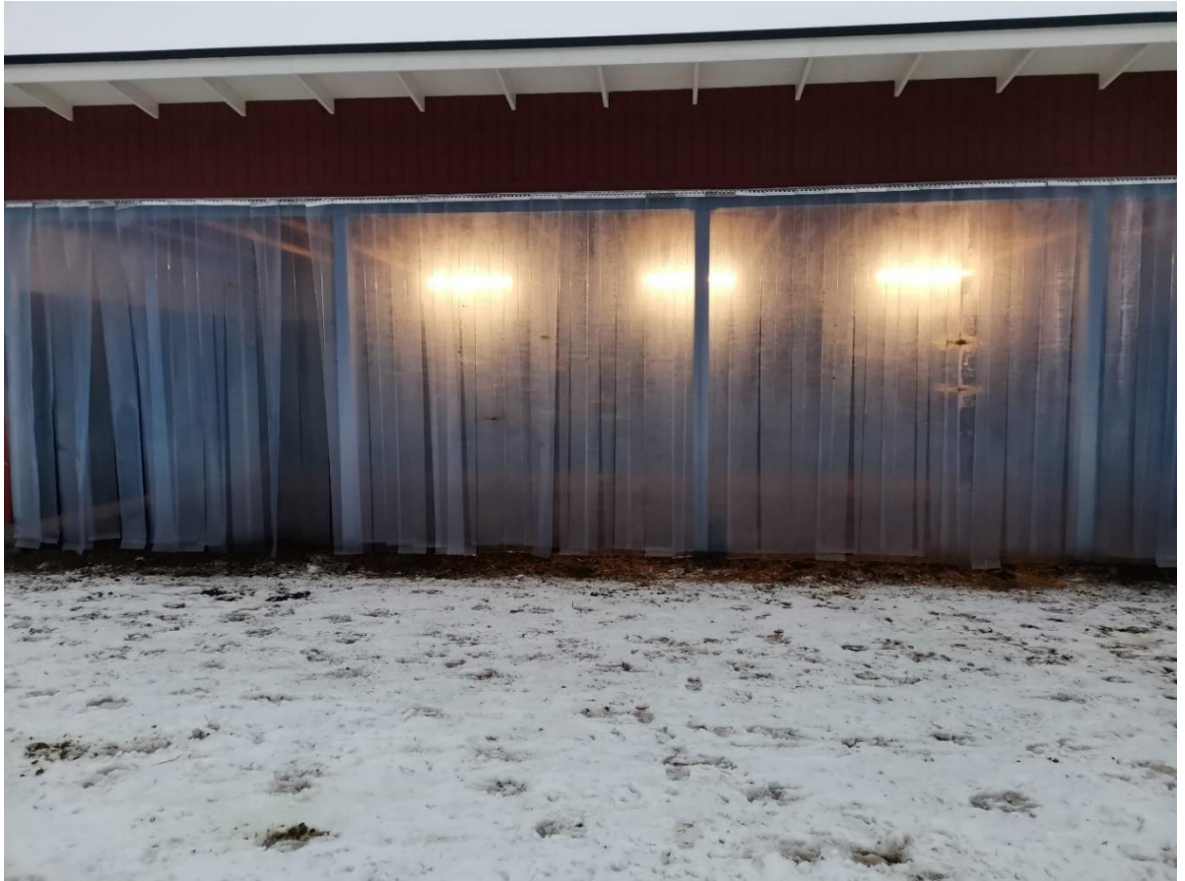
KUVA 14. Makuukatoksen kumihapsut estävät ilmavirran pääsyn katokseen (Räisänen 2021-01-23j)
