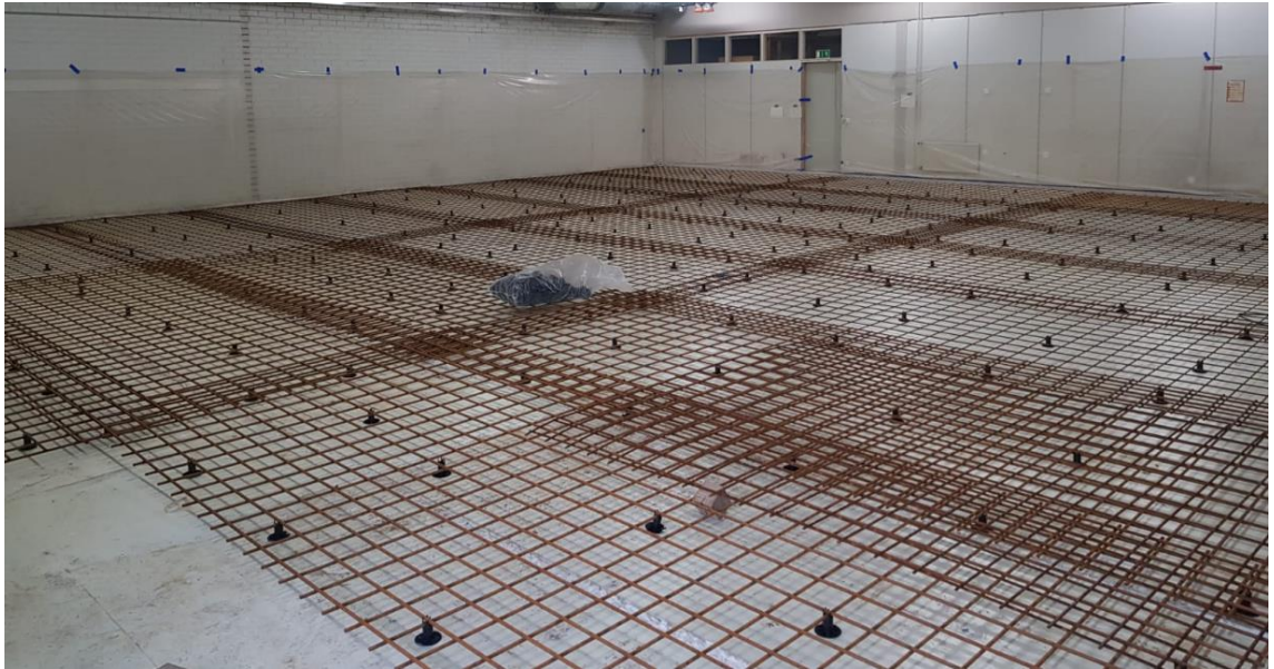
Kuva 3. Lattian raudoitus ennen valua (Mikko Kallioniemi).
