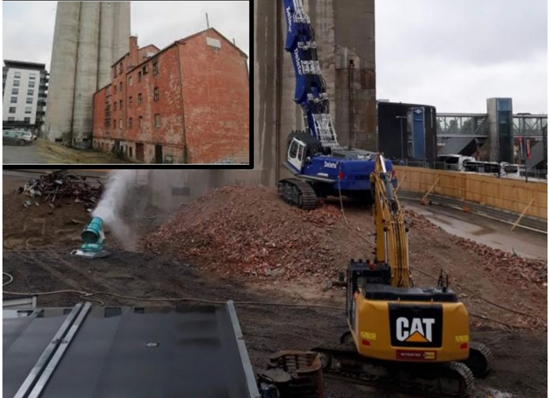
Kuva 28. Savon Valssimylly Oy:n myllyrakennus ja viljasiilojen purkamista (Mikkelin kaupunki 2017b)
