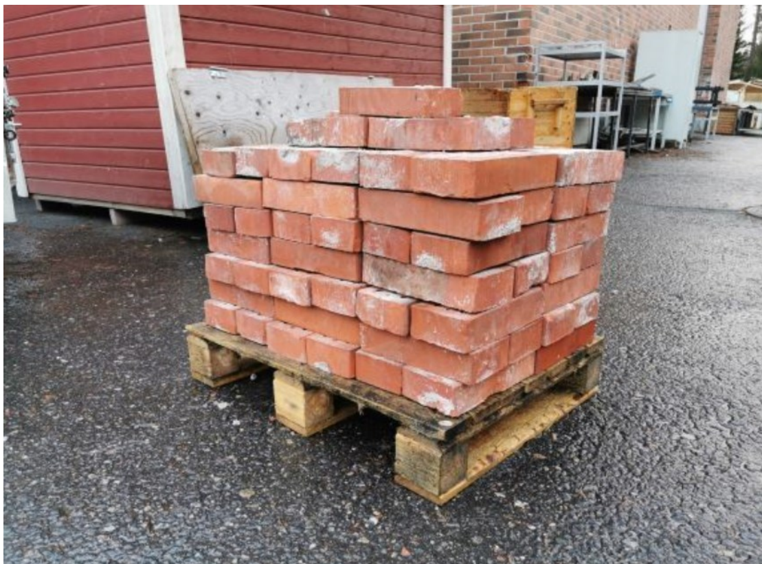
Kuva 31. Tuukkalan sairaalarakennuksesta purettuja tiiliä varastoituina (Pylkkänen 2020)
