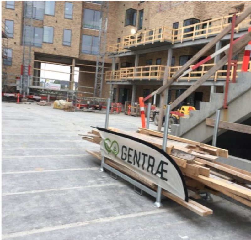
Kuva 11. GENTRÆ-palvelun kierrätyskehikko työmaalla (Stark 2021)
