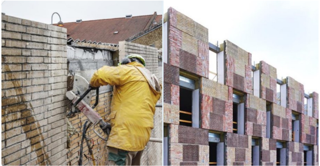
Kuva 21. Tiiliseinän sahausta sekä valmiita seinämoduuleita (Lendager Group 2020)
