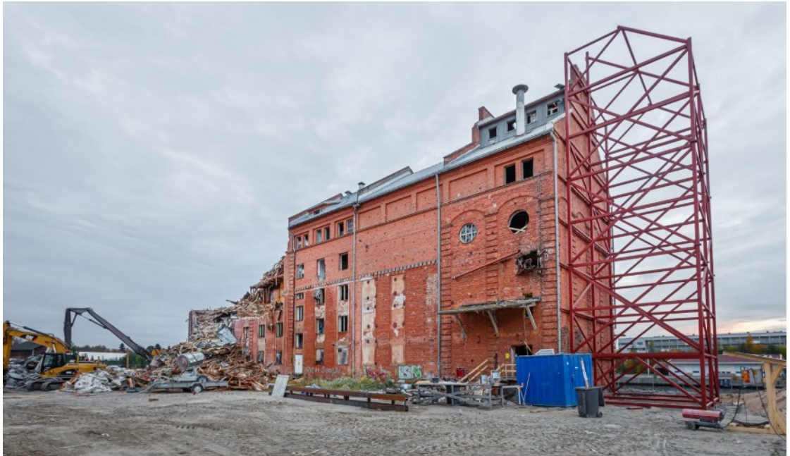
Kuva 25. Vanhan myllyrakennuksen purkamista sekä tuettu pääty (Betoniteollisuus ry 2020)
