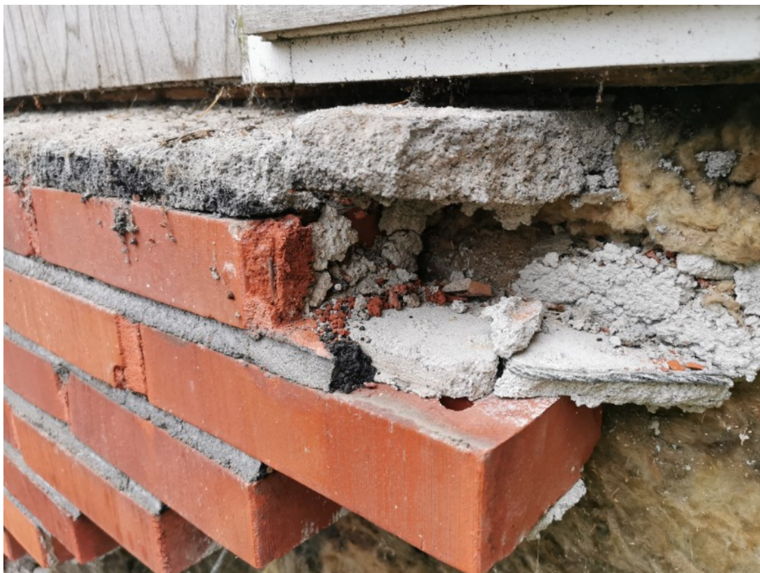
Kuva 30. Tiilien irrottaminen Tuukkalassa, vaihe 2 (Kohvakka 2020)
