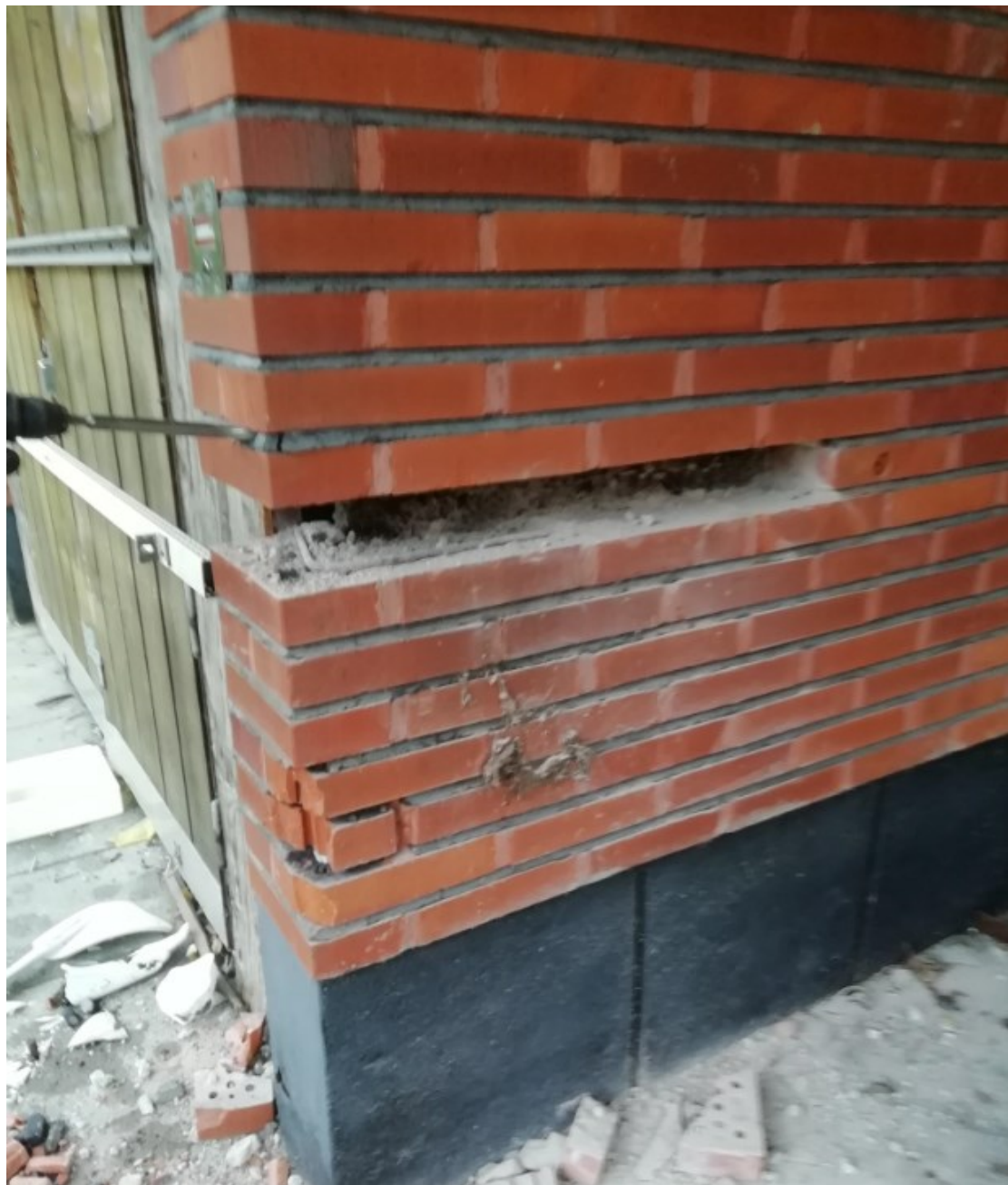
Kuva 29. Tiilien irrottaminen Tuukkalassa, vaihe 1 (Kohvakka 2020)
