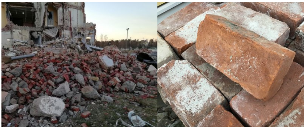
Kuva 32. Urpolan koulun purkutyömaa sekä uudelleenkäyttöön valmisteltu tiili (Kohvakka 2020)
