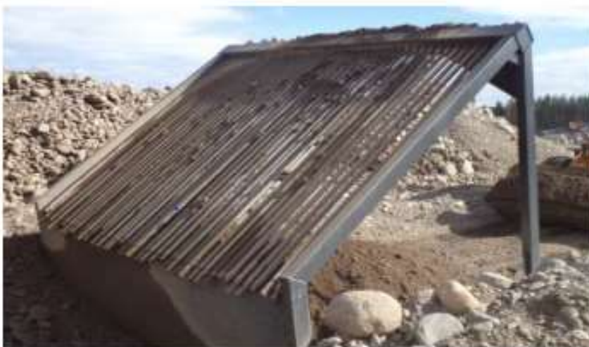
KUVA 13. Kiviaineksen seulonnassa käytettävä välppä (26)
