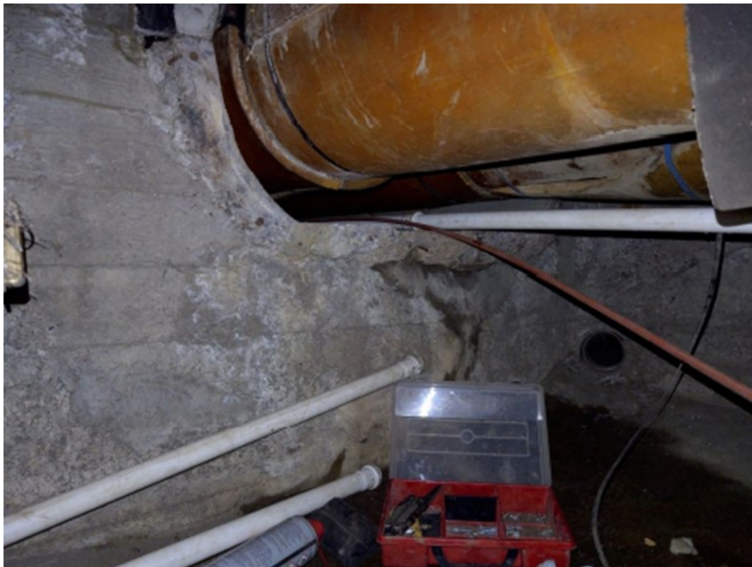
KUVA 10. Kuvauskaapelin syöttö kanavaan. (Suomen Verkostohuolto Oy)
