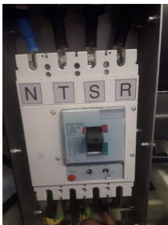
Kuva 17. Laitteiston ylikuormitussuojan ja vikavirtakytkimen yhdistelmä.
