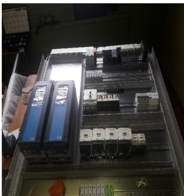
Kuva 15. Keskuskomponentit sijoitettuna pohjalevyille.
