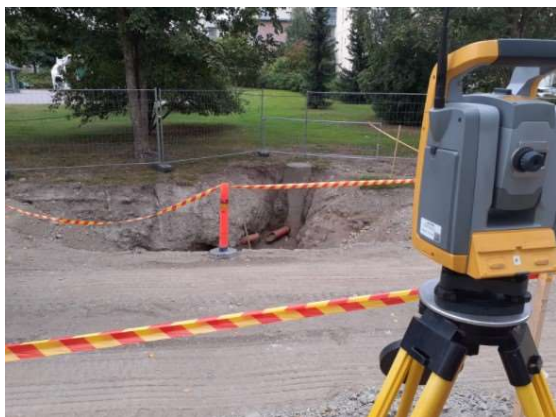
Kuva 15. Kaivon porauskohdanmerkintä laserpisteen ja kynän avulla.
