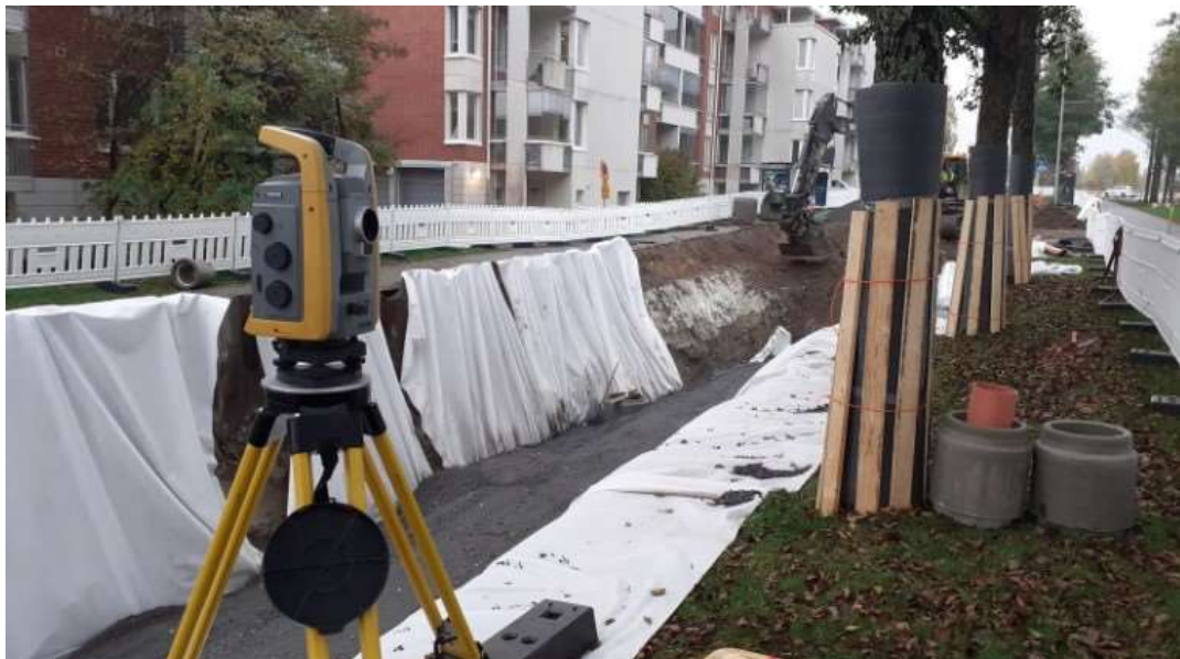
Kuva 11. Ponttiseinän sijainnin tarkemittausta.
