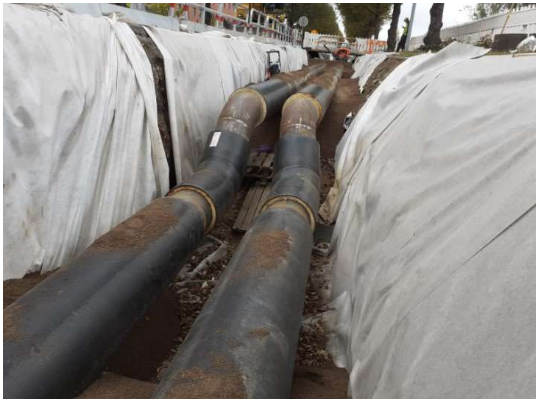
Kuva 10. Kaukojäähdytysputket hitsauksen aikaan.
