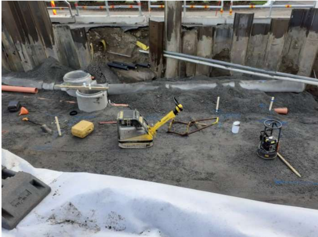
Kuva 12. Hulevesi- ja jätevesiviemäri sekä vesijohdon sijainnin merkintöjä.
