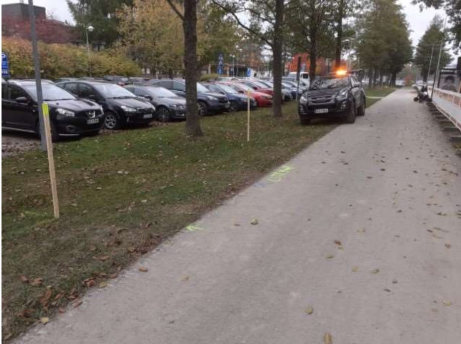
Kuva 13. Tulevan kevyenliikenteenväylän päällysteen reunat paaluilla merkittynä katselmusta varten.
