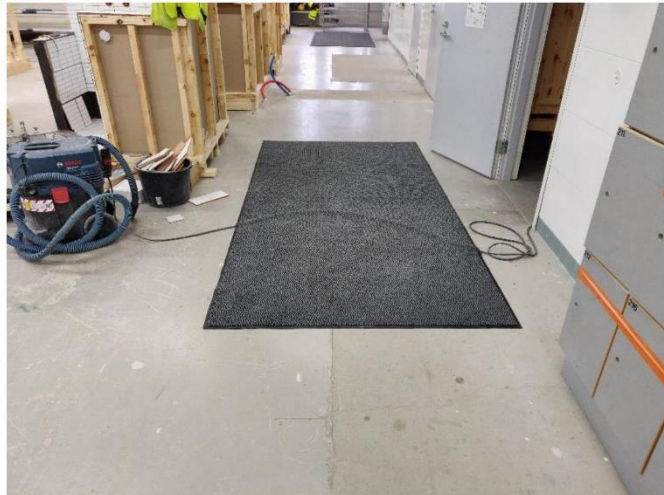
Kuva 13 Vaan näin! Johto maton alta ja yksi kompastuminen estetty.
