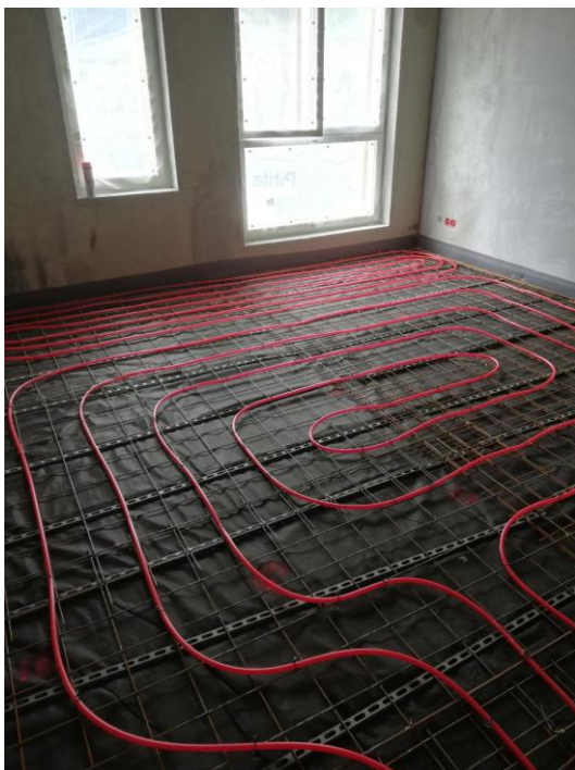
KUVA 1. Lattialämmityspiiri asennettuna uudisrakennuskohteen huoneistoon
