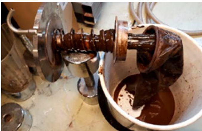
KUVA 10. Sivuvirtasuodattimen pesu ja verkoston huuhtelutarpeen varmistus (KL-Lämpö Oy n.d.)
