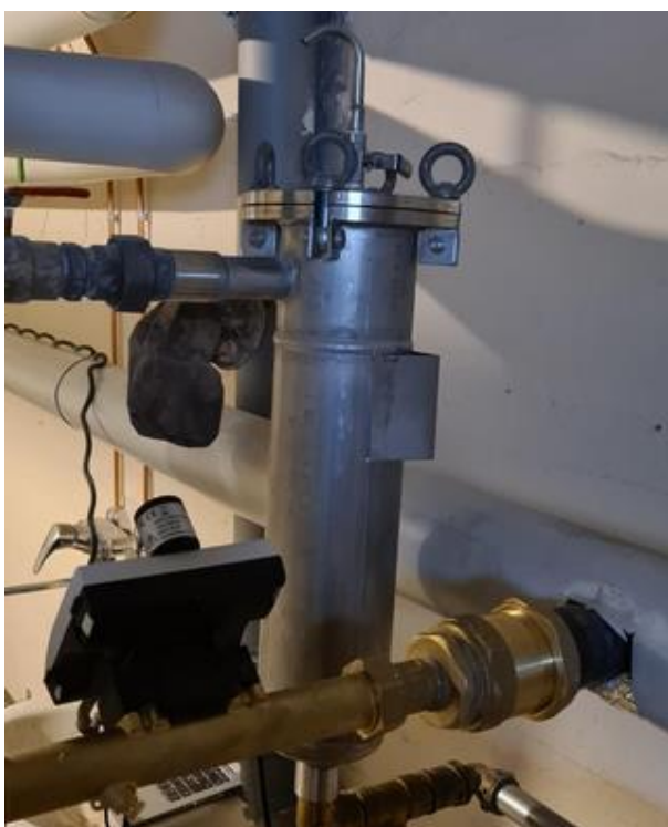
KUVA 8. Magneettinen sivuvirtasuodatin toisioverkostoon asennettuna
