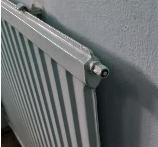
KUVA 4. Vanhan mallinen patterin ilmausruuvi
