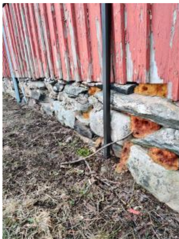
Kuva 5 Sokkeli kellarin pääty
