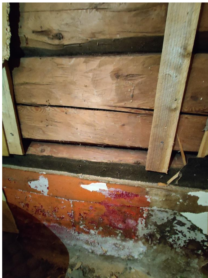
Kuva 38 Hirsinen väliseinä hyvässä kunnossa
