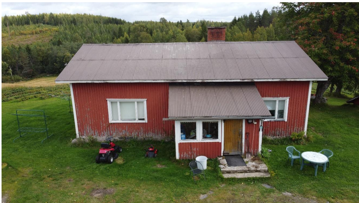
Kuva 1 Tutkittava rakennus (Havukainen 2020)
