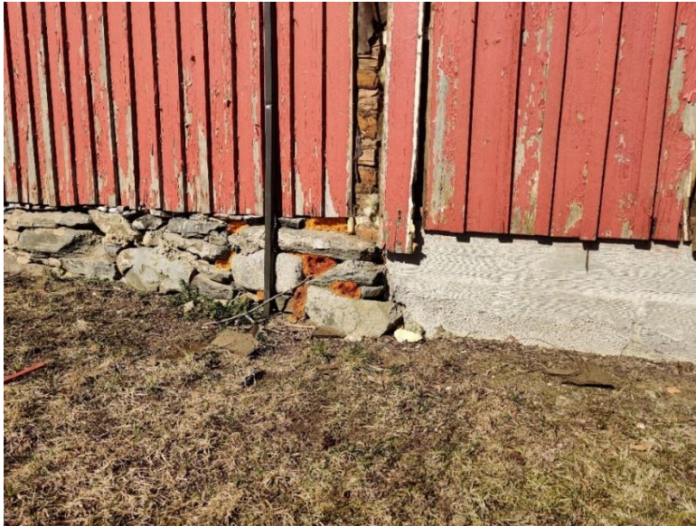
Kuva 3 Vasemmalla vanha sokkeli ja oikealla laajennuksen sokkeli (Havukainen 2021)
