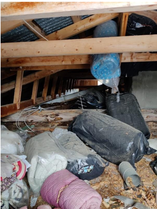
Kuva 29 Yläpohjatilassa säilytetty tavaraa
