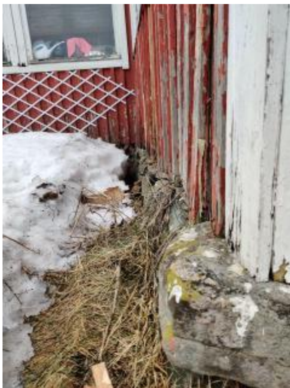
Kuva 4 Sokkeli etupihan puolelta
