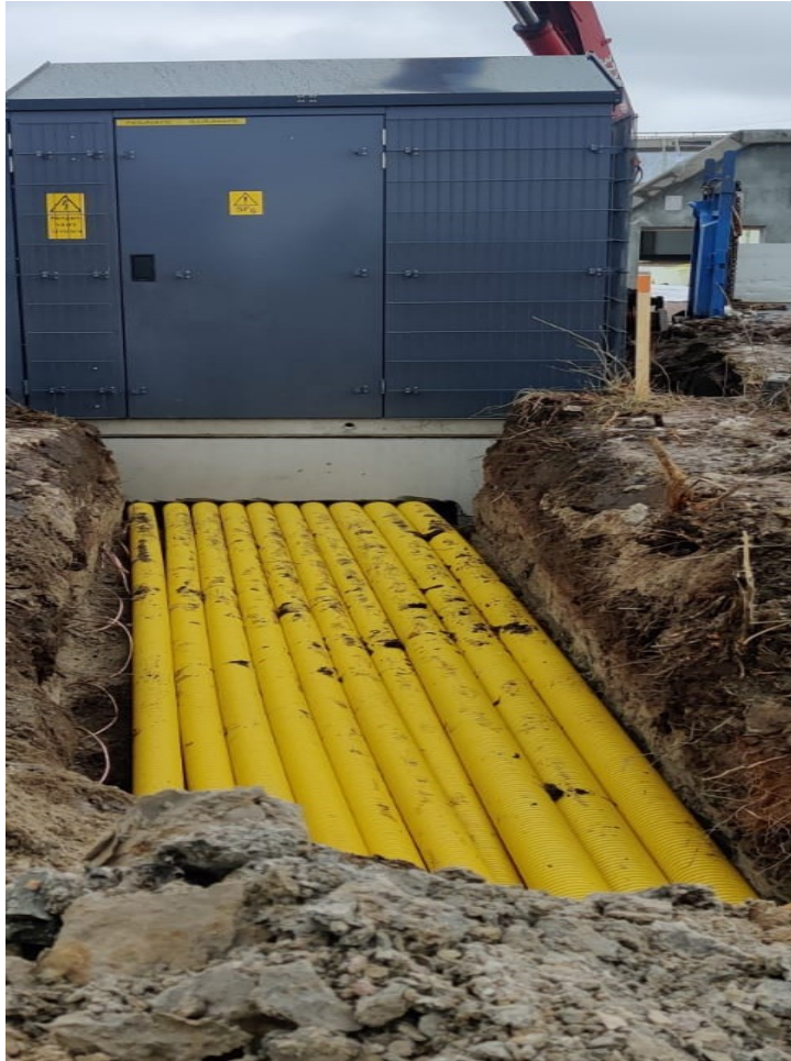
KUVA 13. Kaapelimatton sijainti mitataan keskeltä kaapelimattoa ja kaapeleiden lukumäärä merkitään mittauksen yhteydessä (Tikkanen, 2021).
