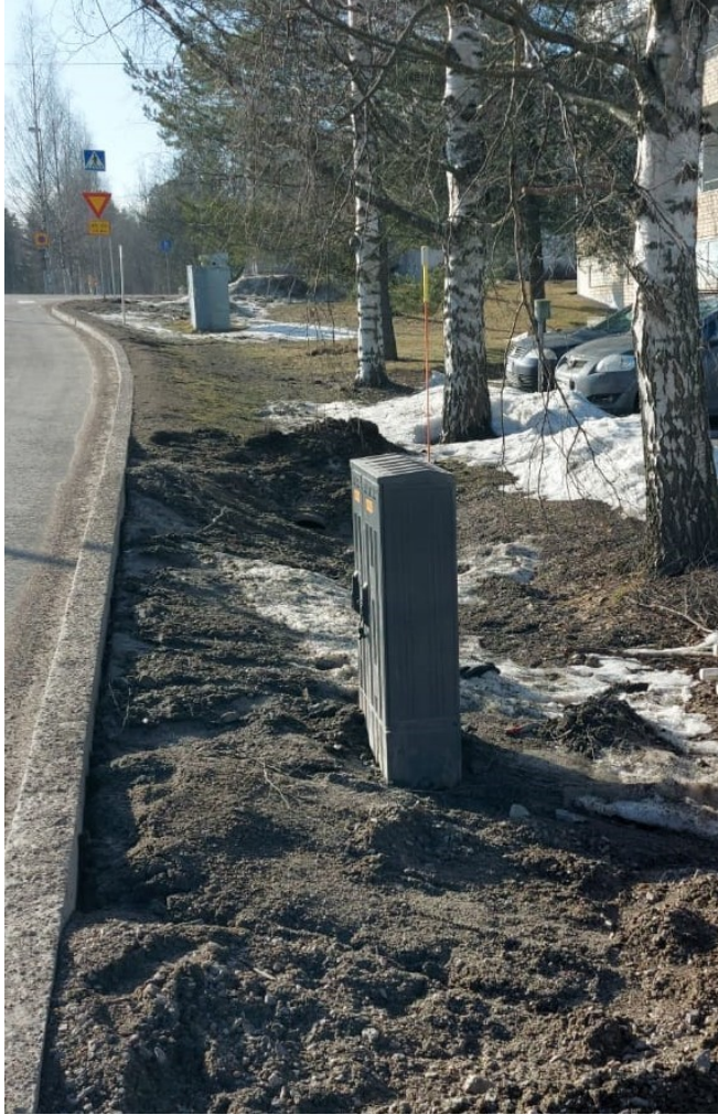
KUVA 5. Uudet yhdistemäkaapit sijoitetaan Caruna Espoo Oy:n verkossa pääsääntöisesti kaupungin alueelle lähelle tontinrajaa. Verkon kohteille haetaan aina sijoituslupa kaikilta osapuolilta, joiden tontille ollaan sijoittamassa verkon kohteita (Tikkanen, 2021).
