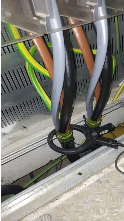
KUVA 7. Pihtimuuntaja kytketään kaikkien vaiheiden ja maadoitusjohtimen ympärille (Tikkanen, Ohjeistus sähköverkon sijaintikartoitukseen tilaajan sähköverkossa, 2021).
