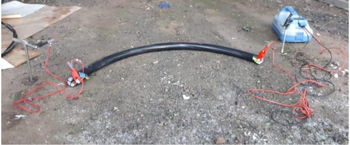
KUVA 6. Demonstraatiokuva galvaanisesta kytkennästä. Kaapeli maadoitetaan kummastakin päästä, jolloin kaapelista ja lähettimestä saadaan muodostettua suljettu virtapiiri (Tikkanen, Ohjeistus sähköverkon sijaintikartoitukseen tilaajan sähköverkossa, 2021).
