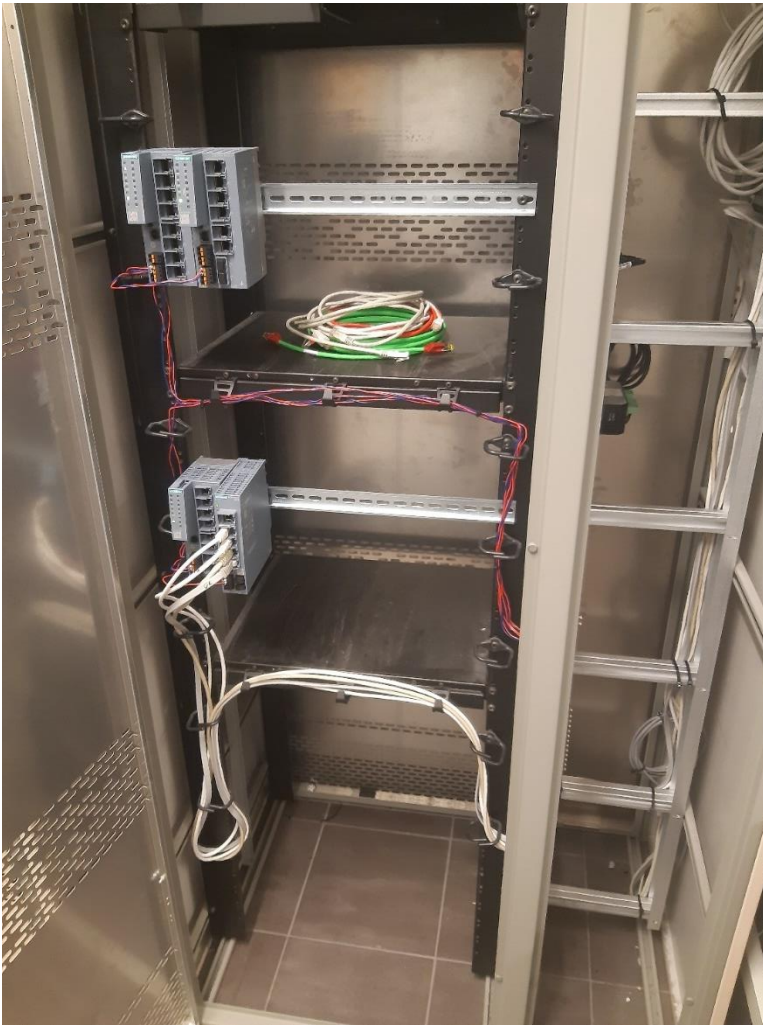
Kuvio 27. Verkkolaitteiden asennus ja kaapelointi
